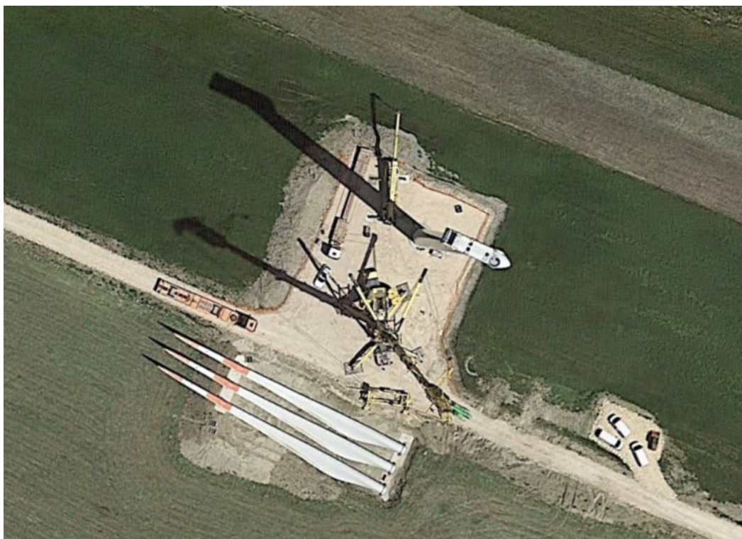
Figura 2.5 – esempio di piazzola in fase di costruzione
