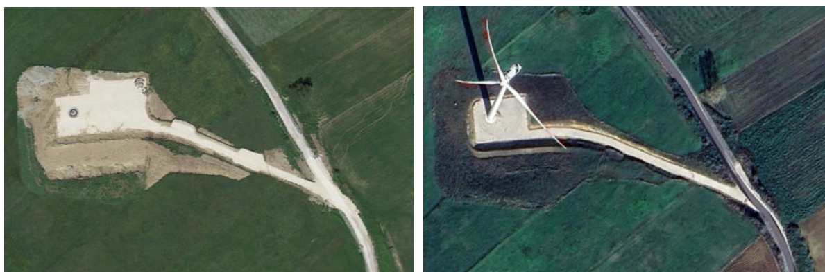
Piazzola in fase di cantiere
