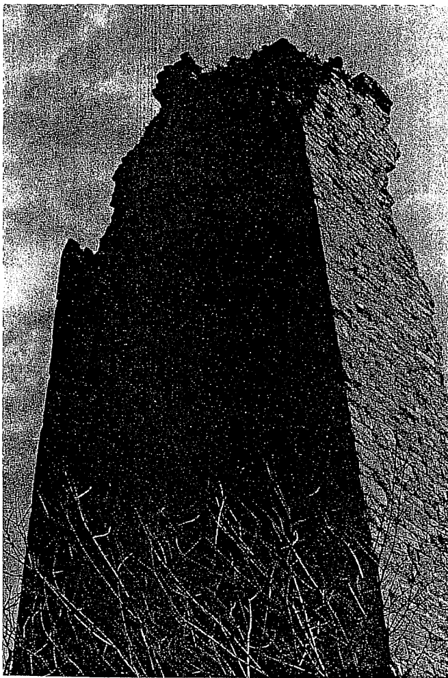
Figg. 30-31 - Torre dell'Aquila: versante SO con le tracce degli archetti ciechi del coronamento originale, sezione Est.
