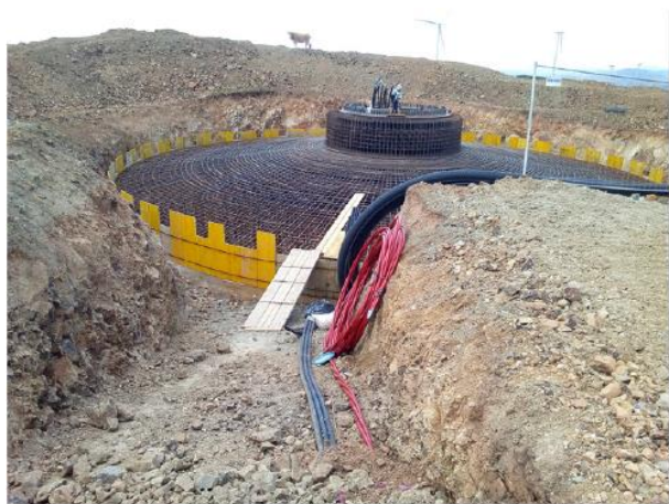
Posa ferri e casseraura
