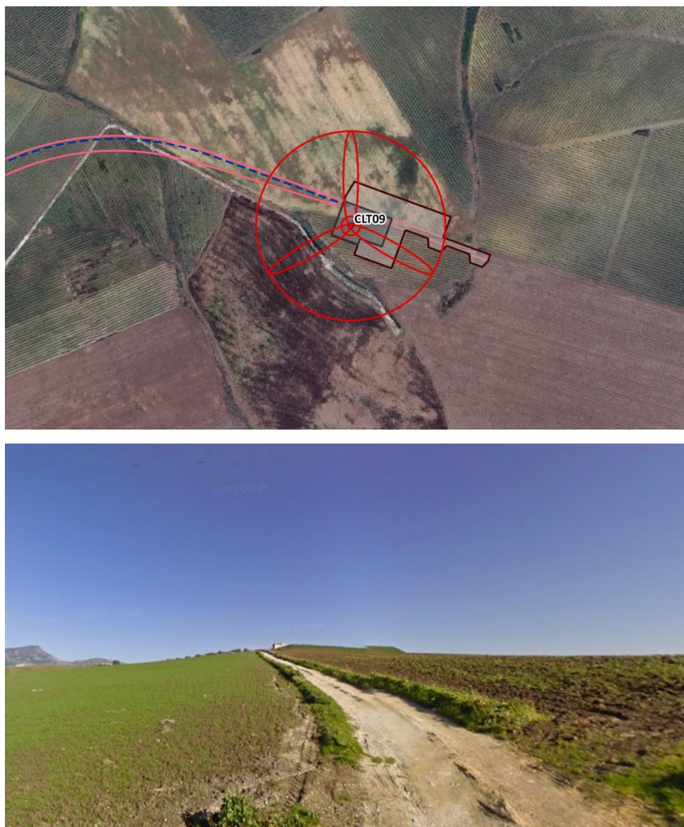
Figura 5.14: Sopra: dettaglio della localizzazione della WTG e delle relative piazzole su ortofoto. Sotto: foto di sopralluogo in cui è visibile in lontananza l'area della prevista WTG.
