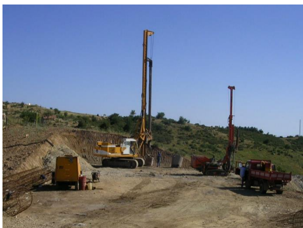
Realizzazione pali trivellati
