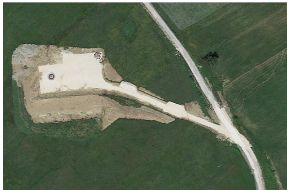
Piazzola in fase di cantiere
