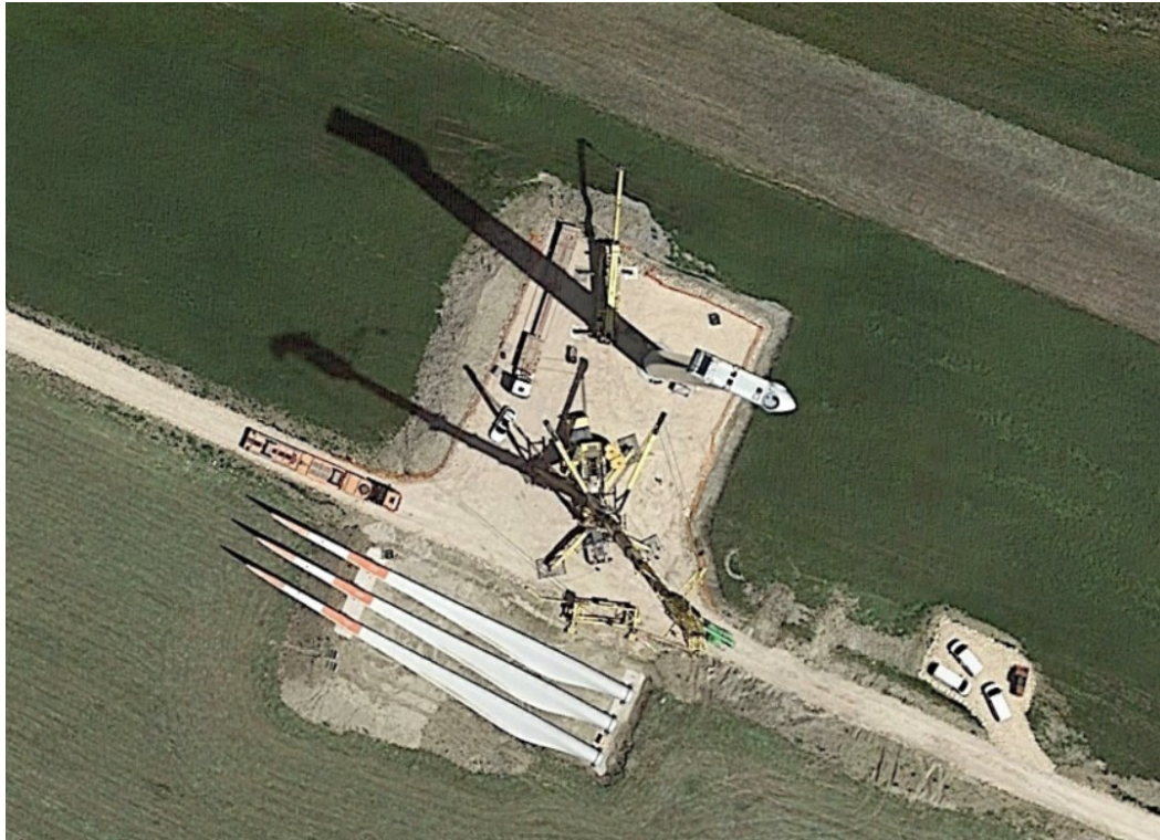
Figura 4.14: esempio di piazzola in fase di costruzione
