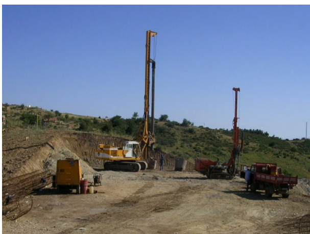
Realizzazione pali trivellati
