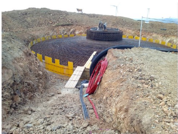
Posa ferri e cassetatura
