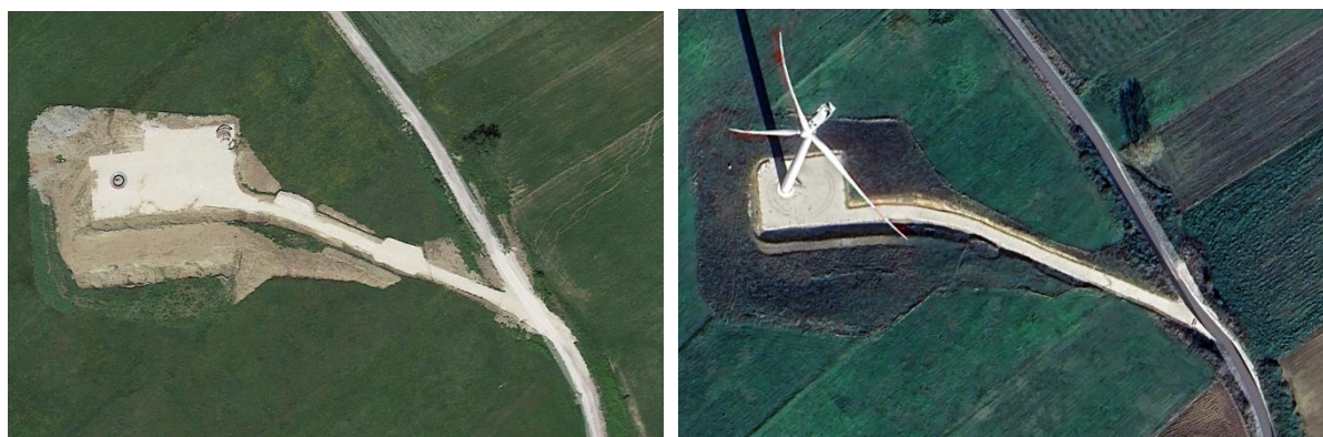
Piazzola in fase di cantiere
