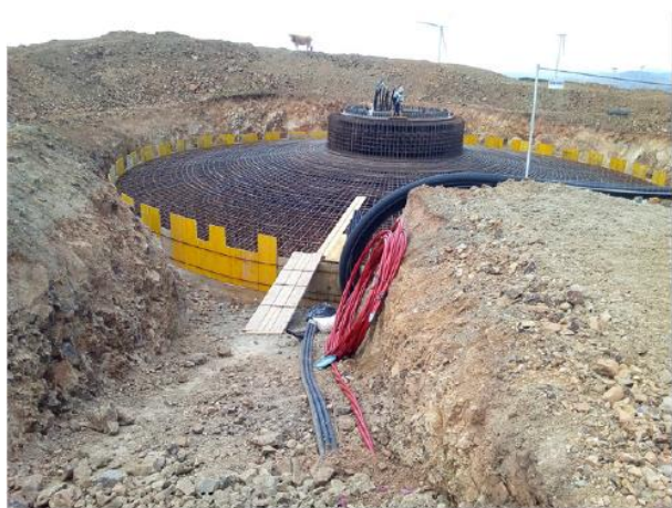
Posa ferri e casseratura
