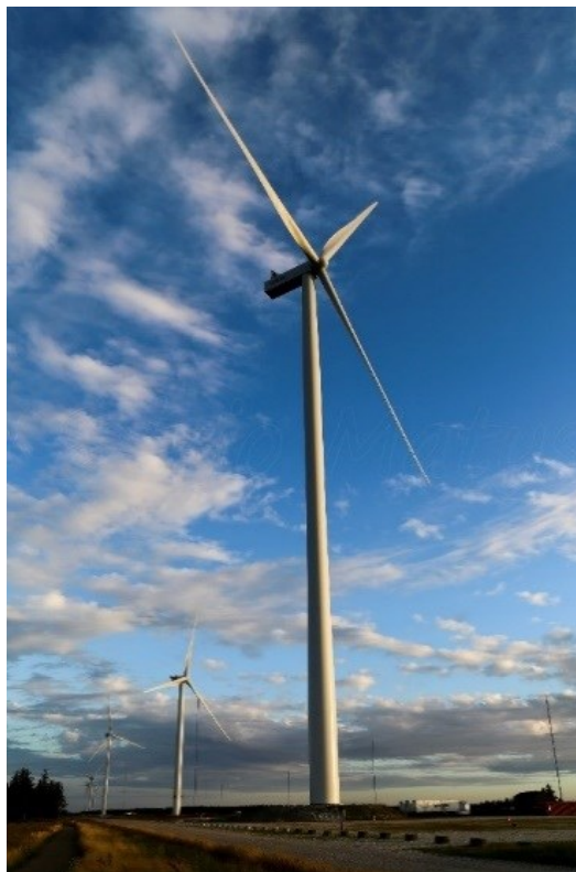
Figura 7 – Aerogeneratore Vestas V150
