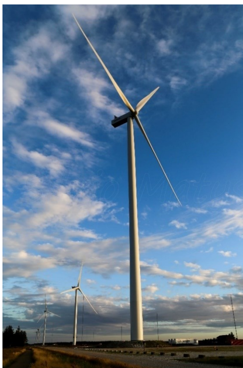
Figura 3 – Aerogeneratore Vestas V150
