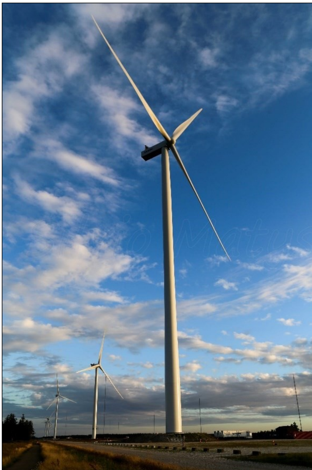
Figura 3 – Aerogeneratore Vestas V150
