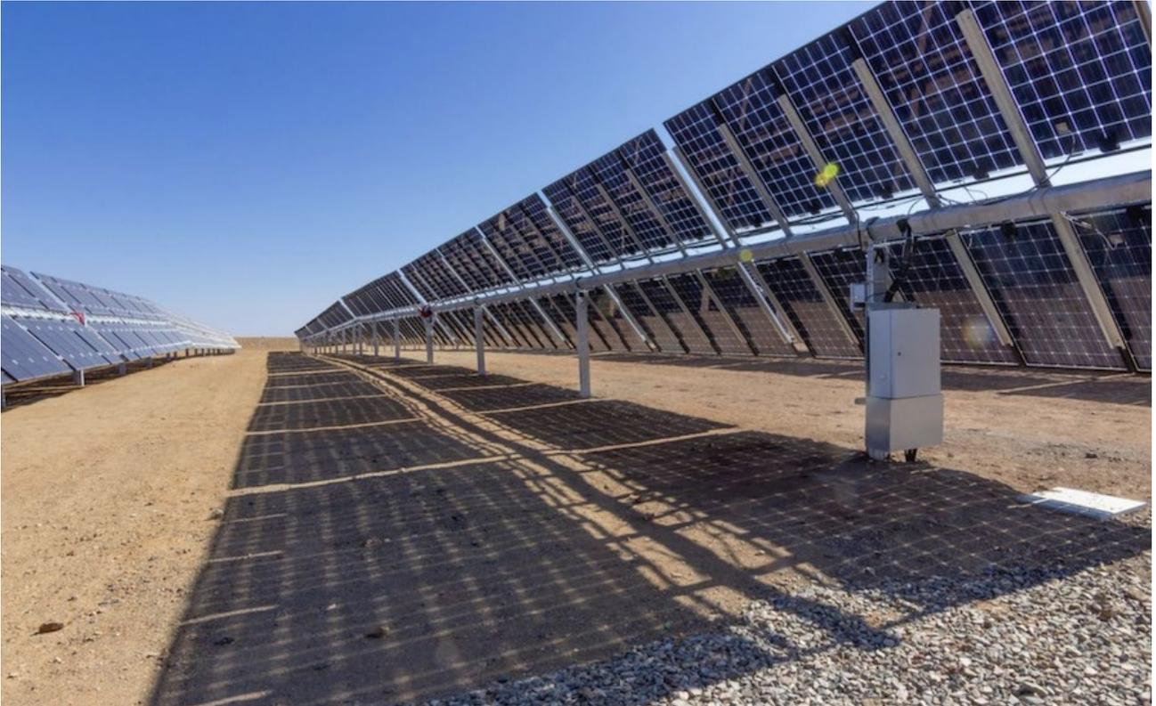
Figura 14 – Particolare strutture di sostegno impianto del tipo ad inseguimento monoassiale
