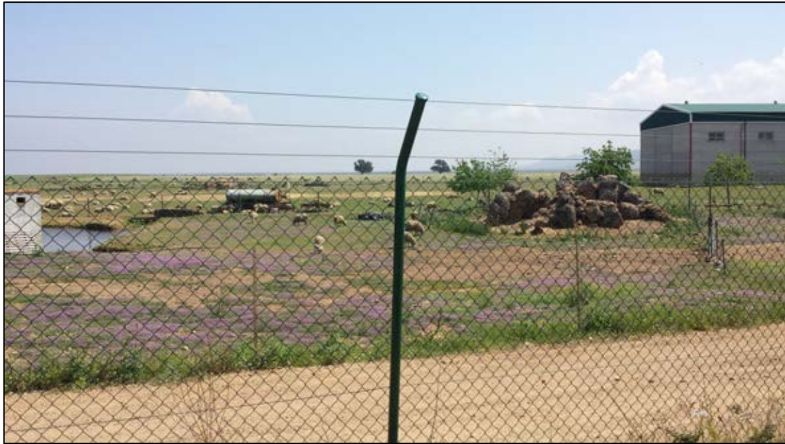
Figura 5: Impianto solare termodinamico Extresol 1-2-3
