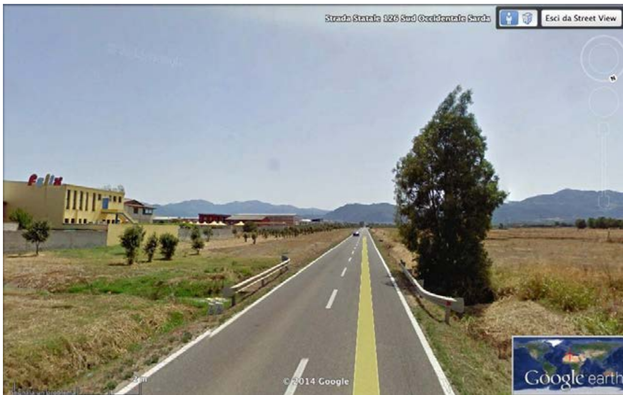
Figura 15: immagine del ponte sul Rio Urralidi
