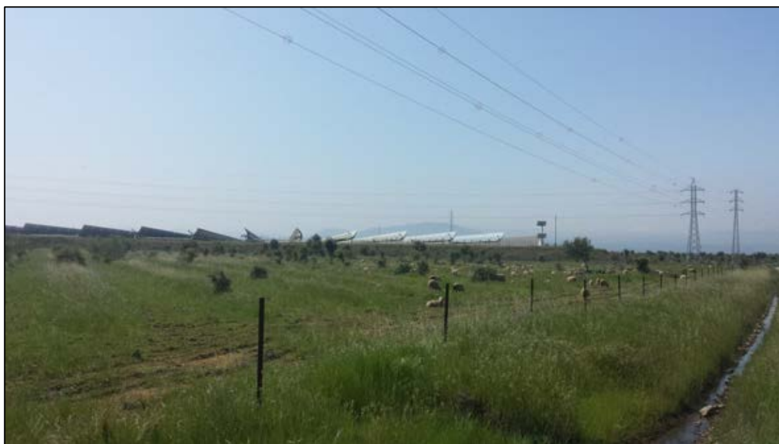
Figura 11: Impianto solare termodinamico Extresol 1-2-3
