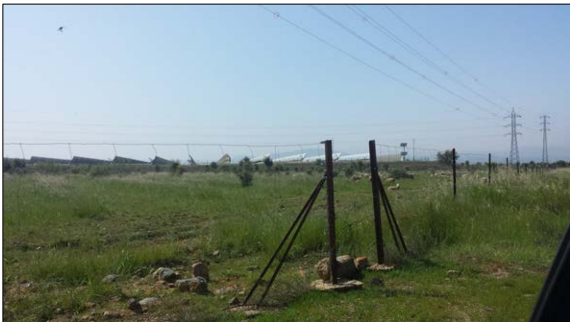
Figura 10: Impianto solare termodinamico Extresol 1-2-3
