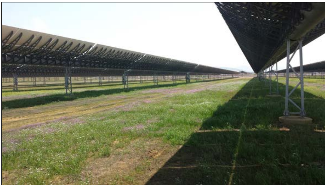
Figura 8: Impianto solare termodinamico Extresol 1-2-3
