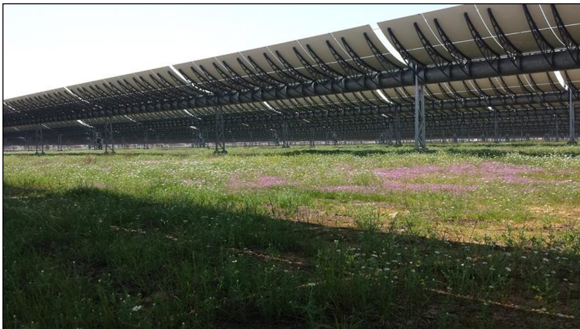
Figura 6: Impianto solare termodinamico Extresol 1-2-3
