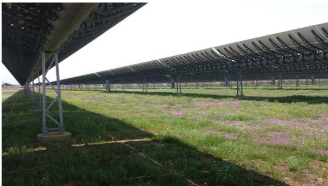
Figura 3: immagine ripresa presso l’impianto solare termodinamico di Extresol 1-2-3 in Spagna
