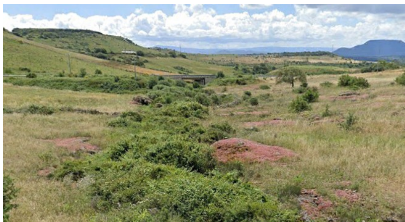
Vista dalla SP68 del tratto del riu a ovest della SS 672 e del tratto di questa in corrispondenza del ponte di sovrappasso del riu
