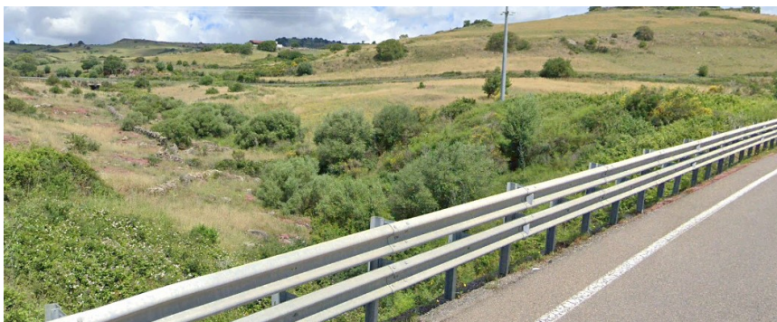
Vista del tratto a ovest della SS 672 – Foto tratta da Street View – giugno 2023
