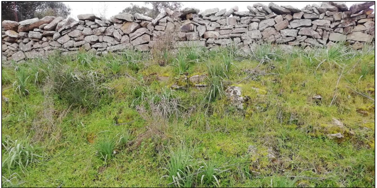
Figura 3.1 - taglio stradale con affioranti i litotipi di origine piroclastica dell'Unità di Chilivani
