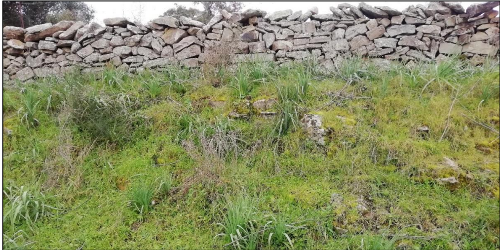
Figura 3.6 - Taglio stradale con affioranti i litotipi di origine piroclastica dell'Unità di Chilivani
