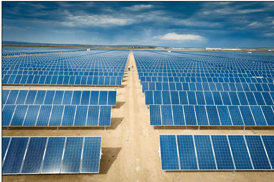
Figura 5.2 - Esempio di struttura di tipo fisso
