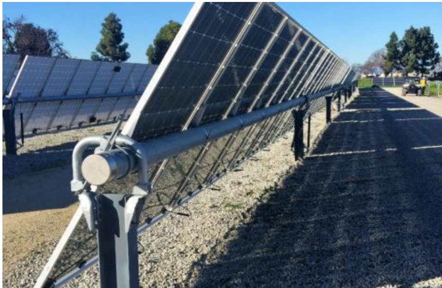
Figura 3.5 - Esempio di struttura di tipo mobile (tracker) monoassiale con configurazione 1p
