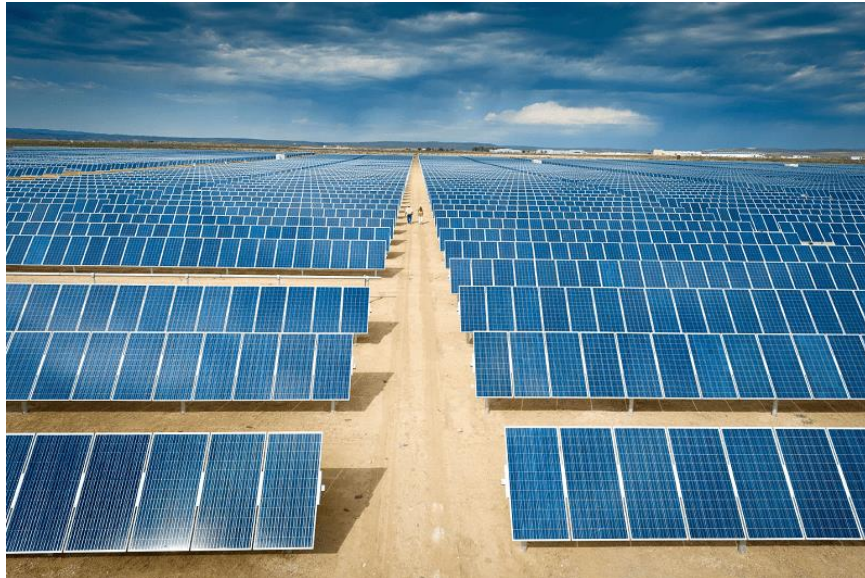
Figura 4.3 - Esempio di struttura di tipo fisso
