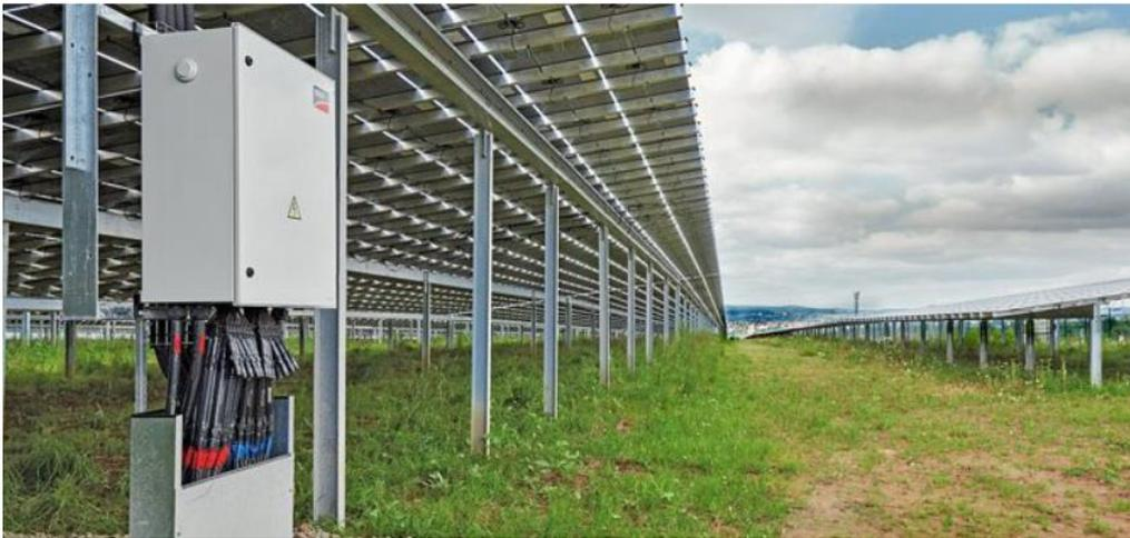
Figura 1 - Esempio di string combiner SMA
