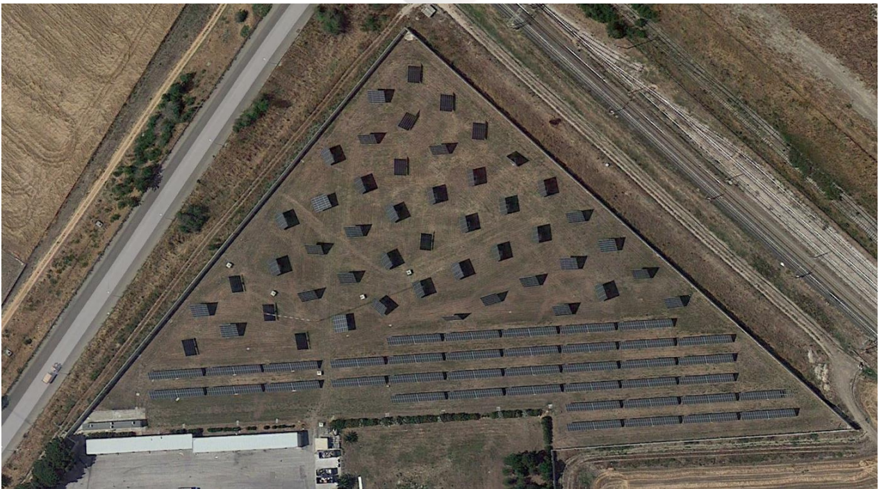
Figura 3-2: Esempio di impianto con inseguitori biassiali a Inconata (FG)
