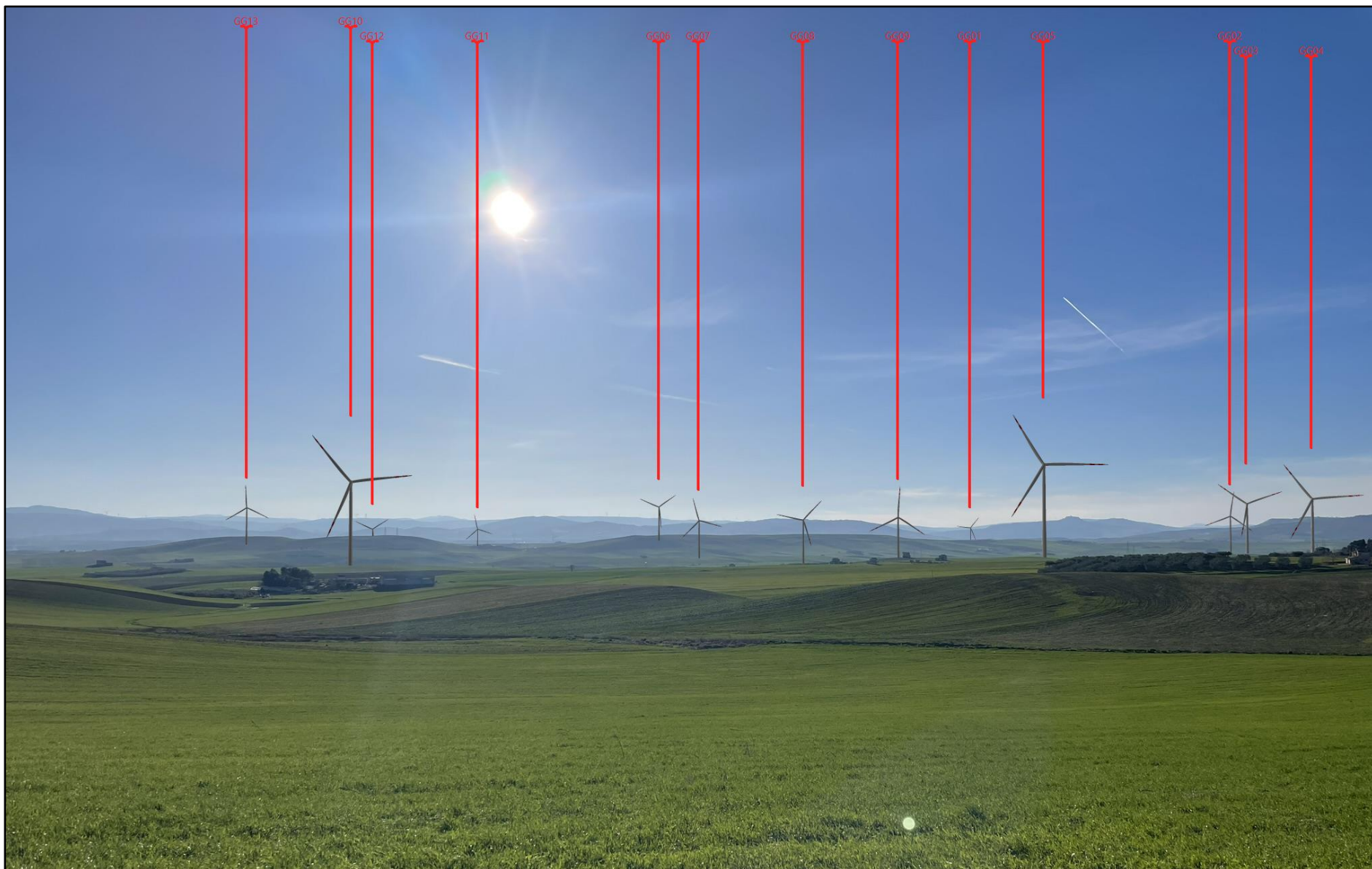
Foto 2.4.3: Tratturo comunale Gravina 3, Comune di Genzano di Lucania - punto di ripresa fotografica F07 (Long. 16,160156° e Lat 40,836278°) - Direzione foto 237° _ Vista area GG01,GG02. GG03, GG04, GG05, GG06, GG07, GG08, GG09, GG10, GG11, GG12, GG13 post operam - Tutti gli aerogeneratori dell'area risultano visibili
