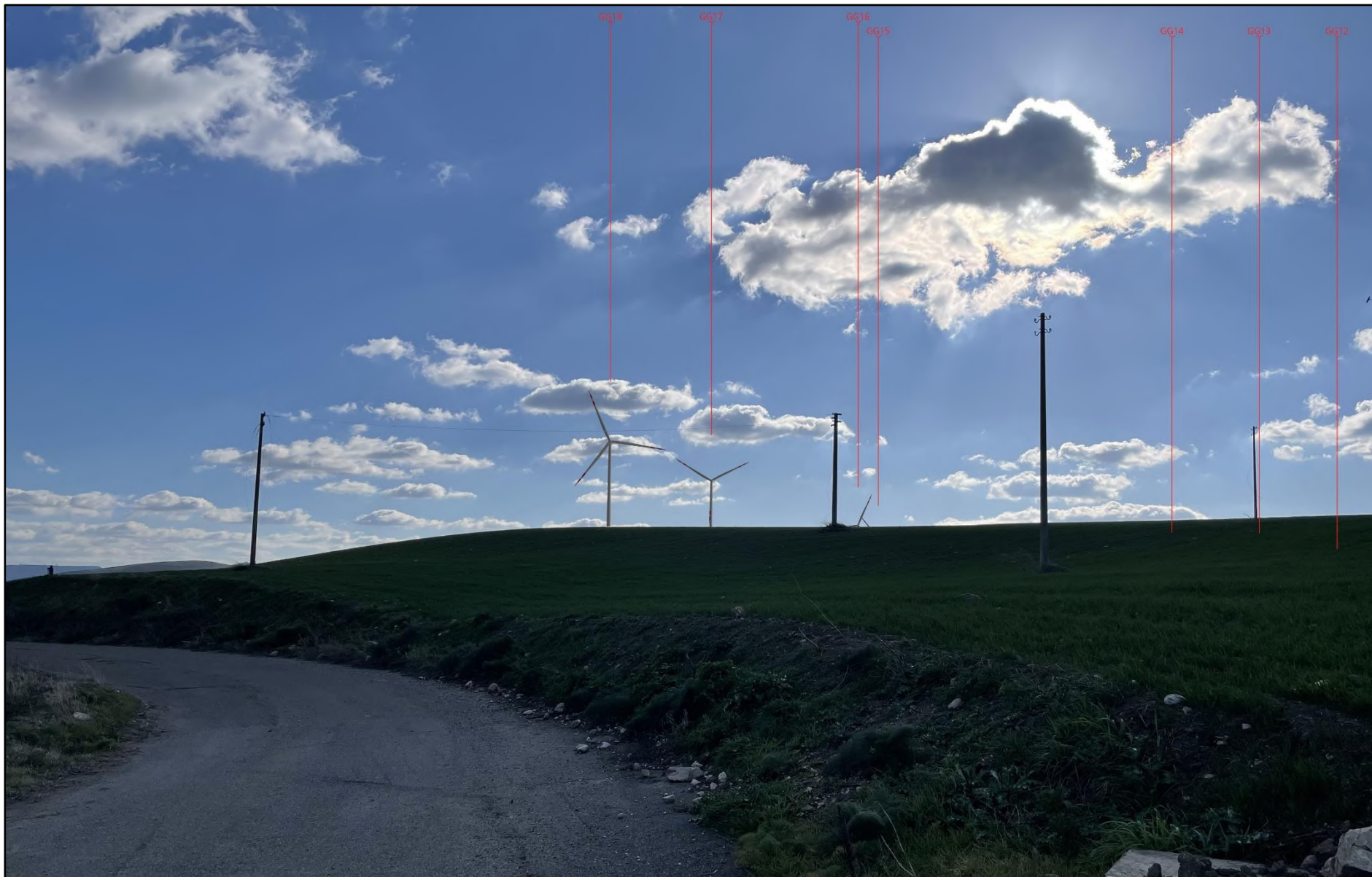
Foto 2.2.3: Tratturo Palazzo-Irsina - SP106, Comune di Genzano di Lucania - punto di ripresa fotografica P36 (Long. 16,184164° e Lat. 40,848592°) - Direzione foto 194°_ Vista area GG12, GG13, GG14, GG15, GG16, GG17, GG18 post opera - Gli aerogeneratori GG15, GG16, GG17, GG18 sono VISIBILI. Tutti gli altri aerogeneratori dell'area risultano NON VISIBILI.
