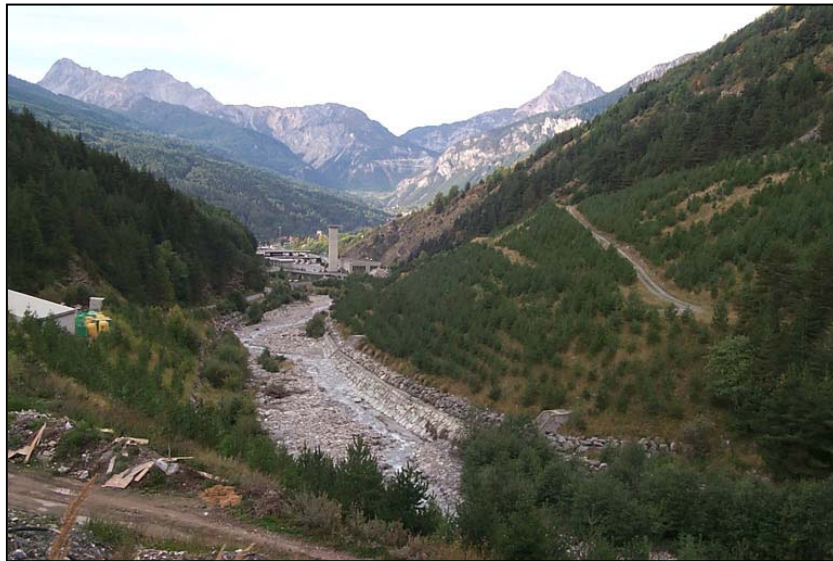
IMBOCCO DEL TUNNEL - Zona deposito
