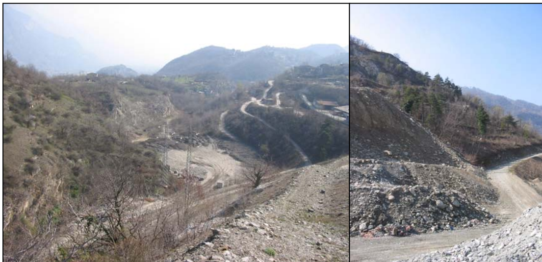
SITO CANTALUPO - PIAN BARALE- Vista del sito di deposito
