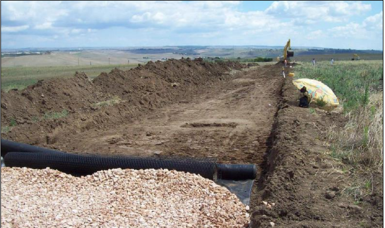
Viabilità brecciata di nuova realizzazione – Fase di scavo superficiale (scotico) si nota il terreno vegetale posizionato a bordo scavo
