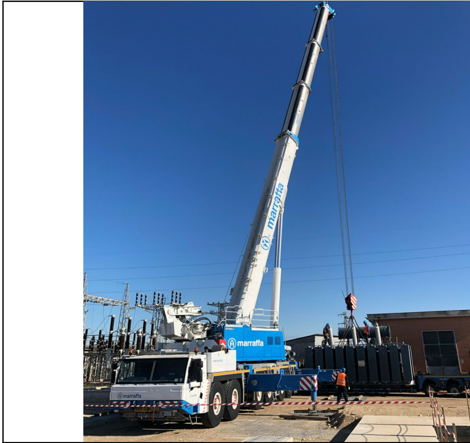
Scarico con autogru
