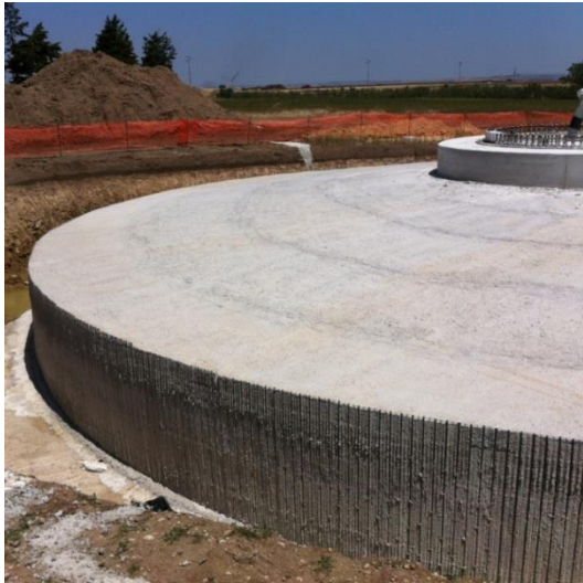
Fig. 0.7 - Tipico fondazione a plinto prima del rinterro
