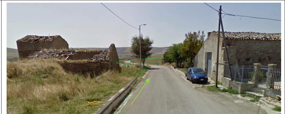
Punto di presa sulla vicinale in attraversamento del borgo LE MEZZANE : Vista del tracciato del cavidotto esterno MT
