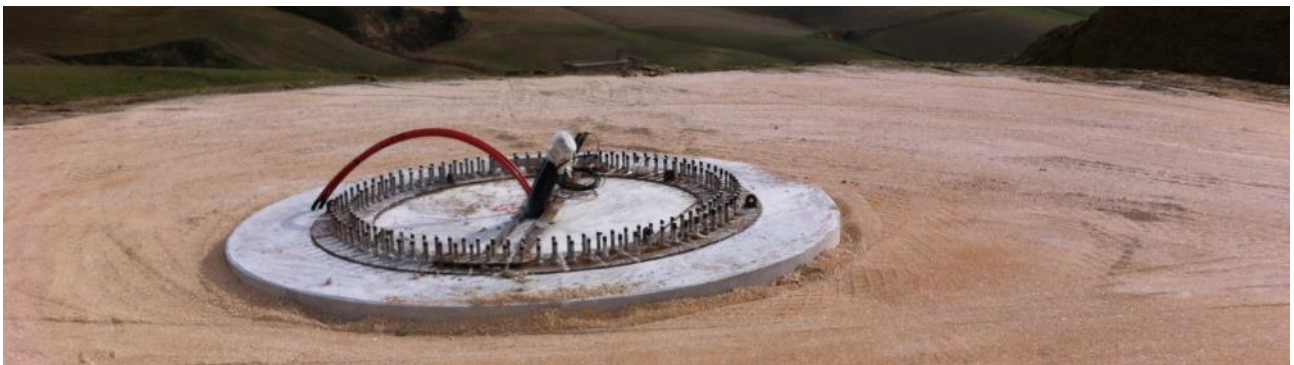
Fig. 0.8:- Tipico plinto interrato ed anchor cage
