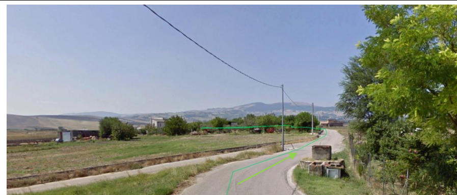
Punto di presa sulla vicinale in arrivo al borgo LE MEZZANE da nord. Vista del tracciato del cavidotto esterno MT
