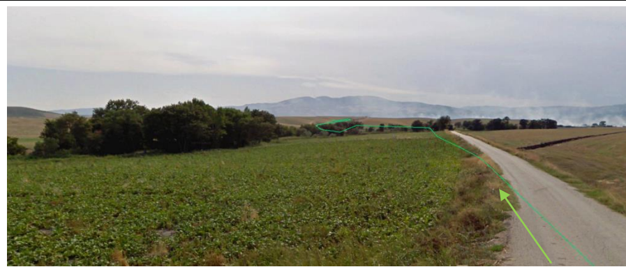
Punto di presa sulle vicinali in prossimità della cabina di sezionamento WTG 7. Vista del tracciato del cavidotto esterno MT
