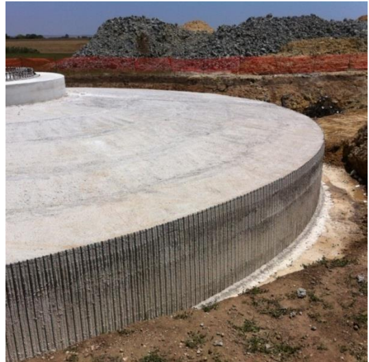
Fig. 0.7 - Tipico fondazione a plinto prima del rinterro
