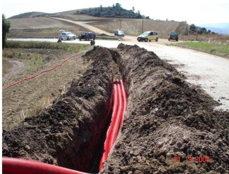
Fig. 0.11: Foto illustrativa della messa in posa dei cavidotti MT
