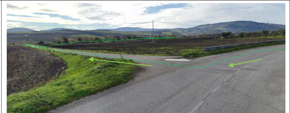
Punto di presa in uscita dalla SP 125 verso la vicinale verso Troia: Vista del tracciato del cavidotto esterno MT
