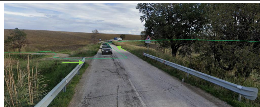
Punto di presa sulla SP 125 in arrivo dalla vicinale: Vista del tracciato del cavidotto esterno MT
