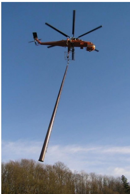
Figura 11-19- Trasporto con elicottero Erickson e montaggio di un sostegno tubolare.
