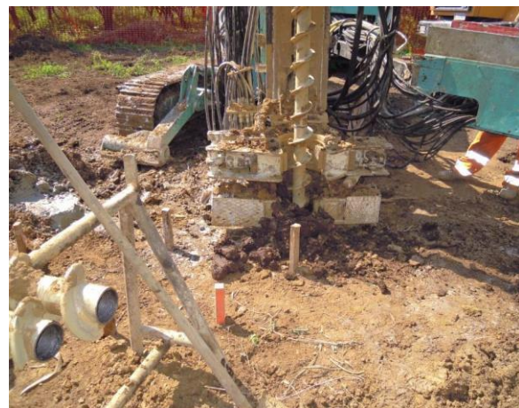
Figura 11-17- Esempio di realizzazione di una fondazione su micropali tipo tubfix.
