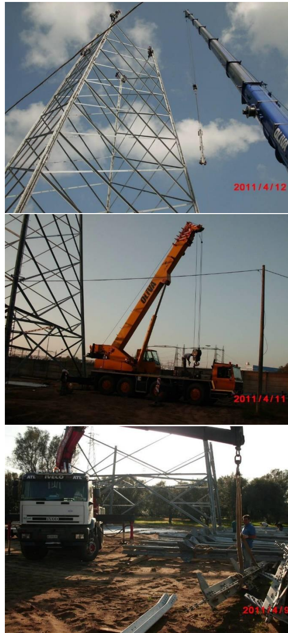
Figura 11-18- Fasi di montaggio sostegno a traliccio.
