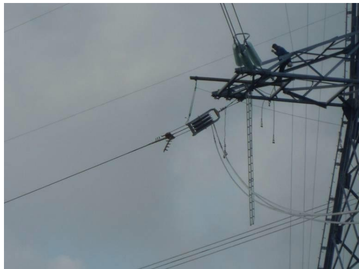
Figura 11-21- Fasi di tesatura della linea elettrica.
