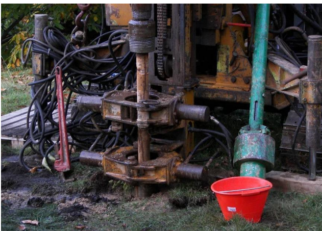
Figura 11-17- Esempio di realizzazione di una fondazione su micropali tipo tubfix.
