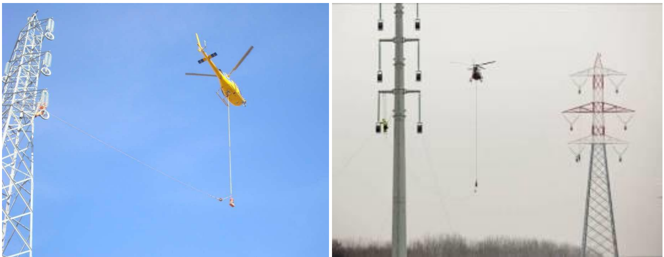
Figura 11-20- Utilizzo dell'elicottero per la stesura della fune
