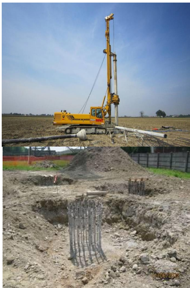
Figura 11-14 Macchina operatrice per la realizzazione di pali trivellati
