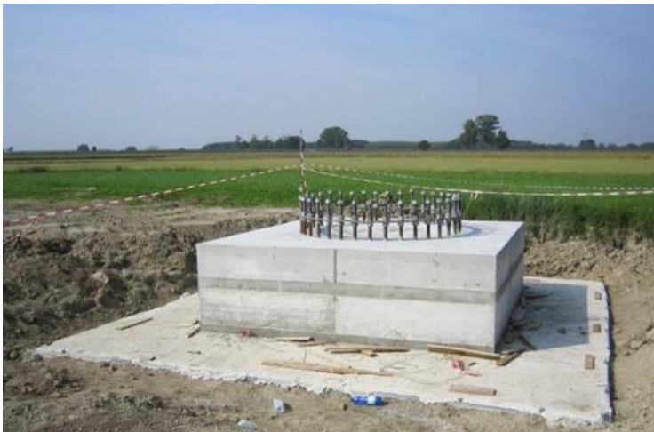
Figura 11-13- Realizzazione di fondazioni superficiali tipo plinto a monoblocco per un sostegno monostelo. A sinistra si può osservare una fondazione appena realizzata, dove si può distinguere facilmente la flangia metallica dotata di tirafondi di raccordo con la parte in elevazione. A destra è riportato un esempio di fondazione completata e la sistemazione del terreno nell'area circostante
