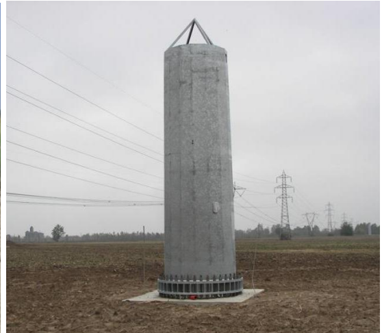
Figura 11-13- Realizzazione di fondazioni superficiali tipo plinto a monoblocco per un sostegno monostelo. A sinistra si può osservare una fondazione appena realizzata, dove si può distinguere facilmente la flangia metallica dotata di tirafondi di raccordo con la parte in elevazione. A destra è riportato un esempio di fondazione completata e la sistemazione del terreno nell'area circostante
