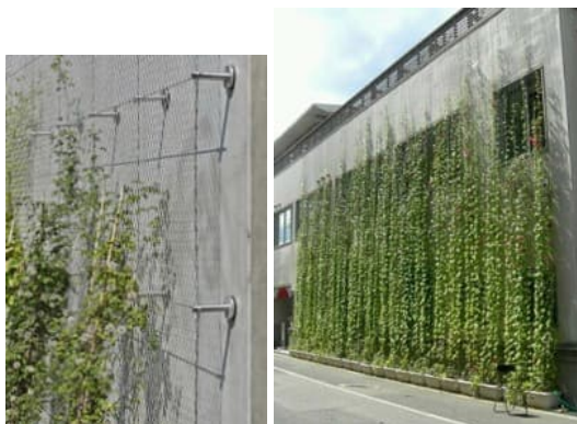
Figura 5-1: Immagini esemplificative di specie rampicanti con crescita lungo cavetti di acciaio verticali.
