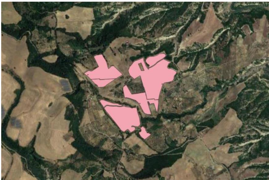
FIGURE 5- VISTA AEREA DELL'AREA DELL'IMPIANTO FV AREA3
