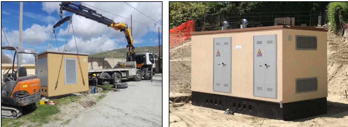
Figura 7 - Fasi di scarico cabine prefabbricate in cav
