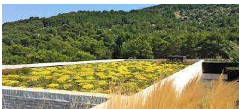
Fig. 3.1 – Esempio di tetto-giardino estensivo con Sedum sp.p.
