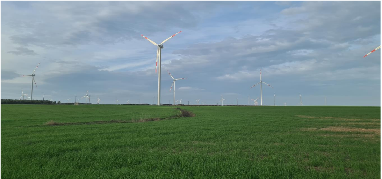
Fig. 4.6 – Foto 5 Altro parco eolico in funzione
