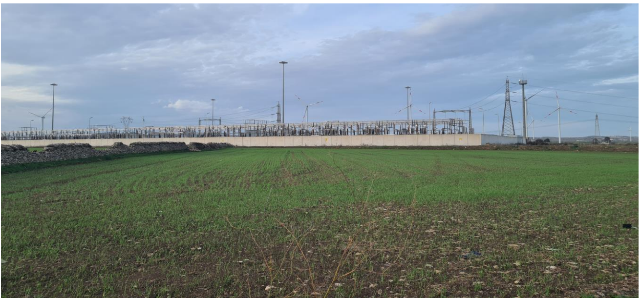
Fig. 4.9 – Foto 8 Stazione Elettrica Terna
