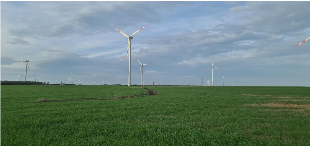
Fig. 1.7 – Foto 5 Altro parco eolico in funzione
