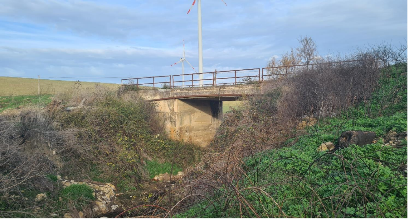
Fig. 1.11 – Foto 9 Ponte su corso d'acqua maggiore
