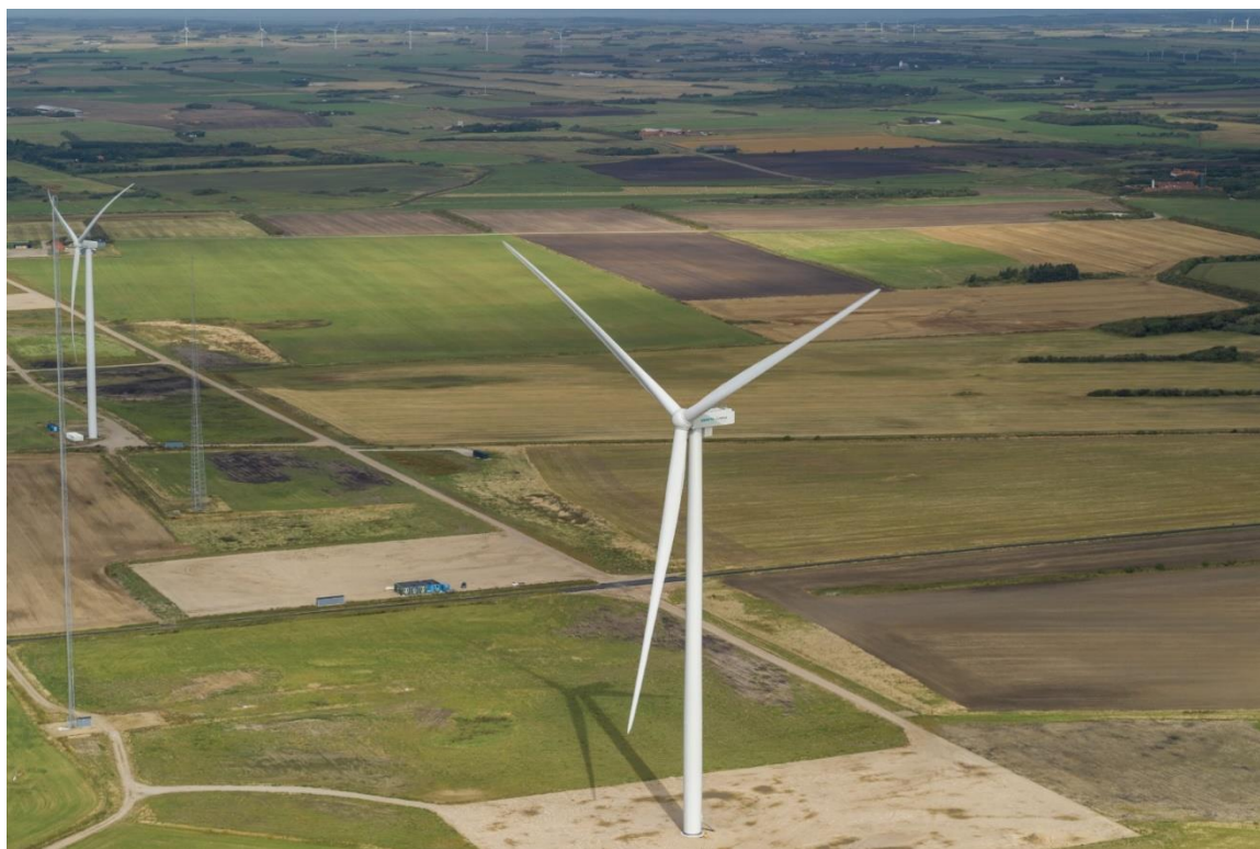
Fig. 3.1 Aerogeneratore Siemens GAMESA SG 6.6 – 170
