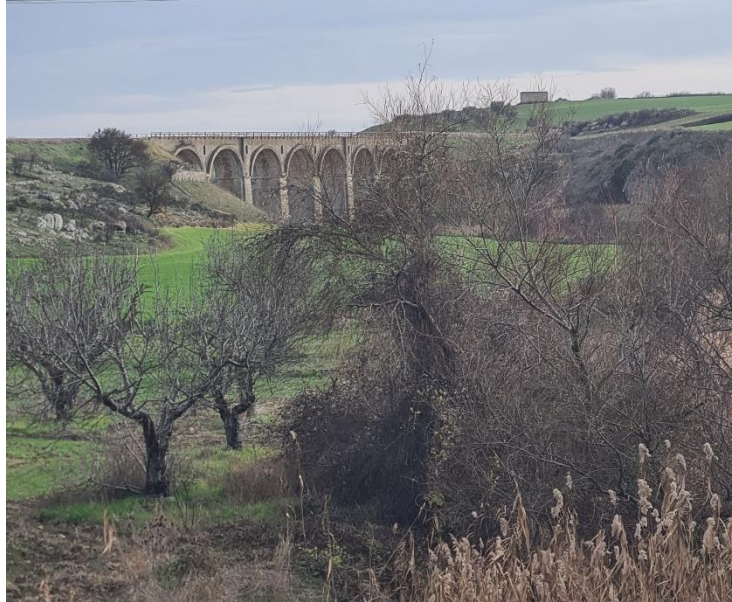
Fig. 1.12 – Foto 10 Viadotto sul corso d'acqua Fiume Iummo
