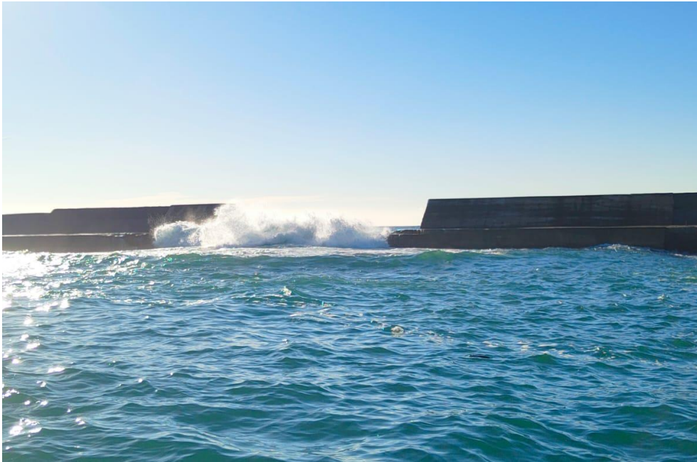
Diga foranea del Canale di calma.
