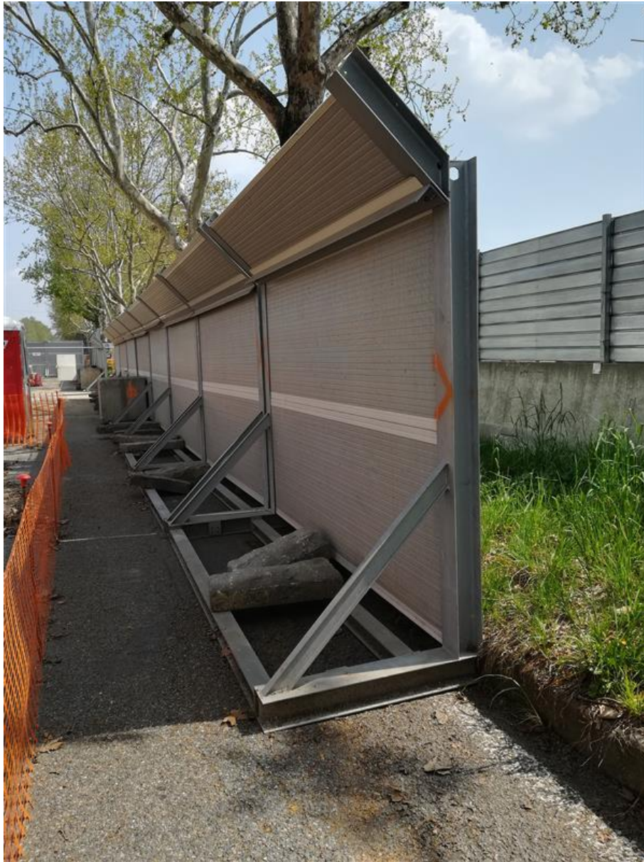
Figura 30 – Barriere mobili da posizionare al perimetro di cantiere
