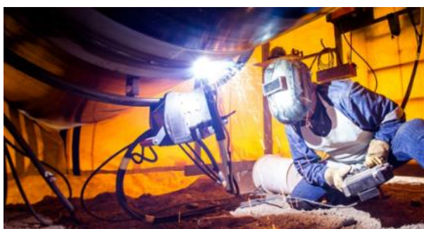
Figura 6 – Saldatura orbitale automatizzata
