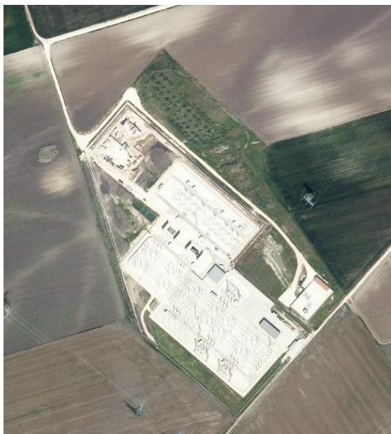
Ortofoto stato di fatto
