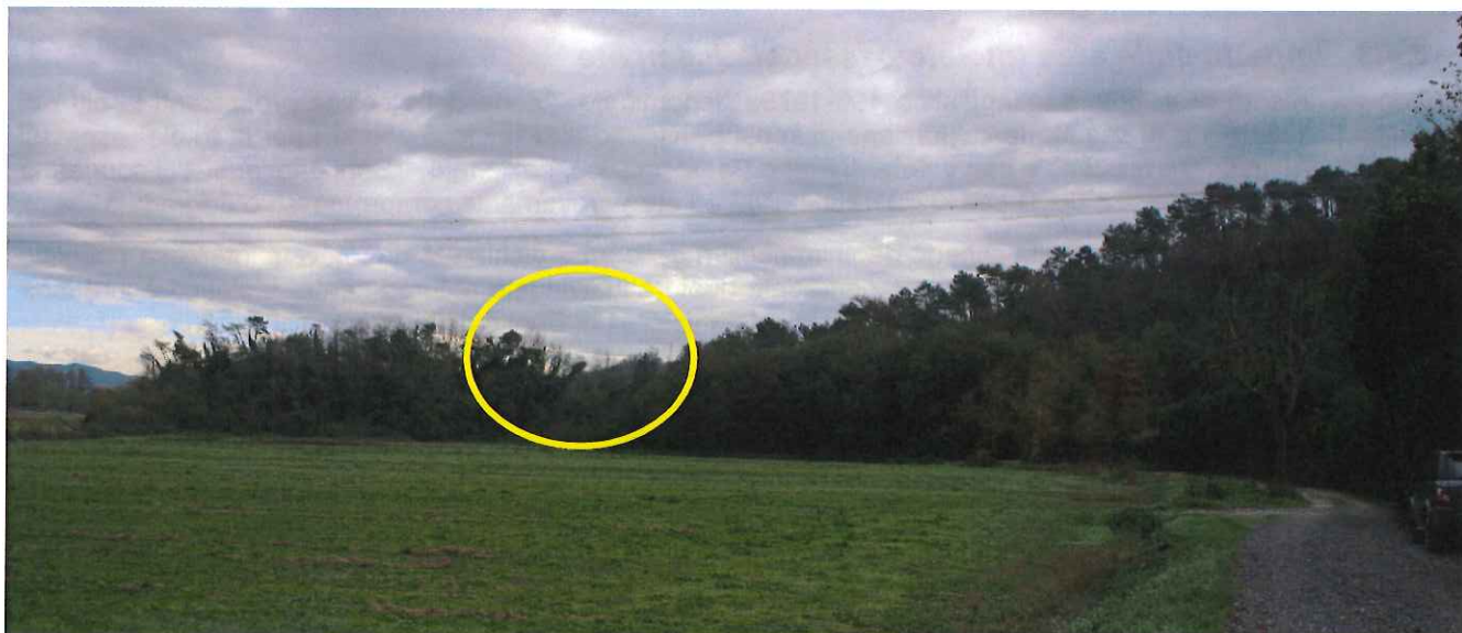
Figura 6.4-15: Vista in prossimità di Villa Poggio Luce in direzione Nord-Est. In giallo è evidenziata la posizione approssimativa del collocamento del sostegno n. 60 della linea autorizzata.
