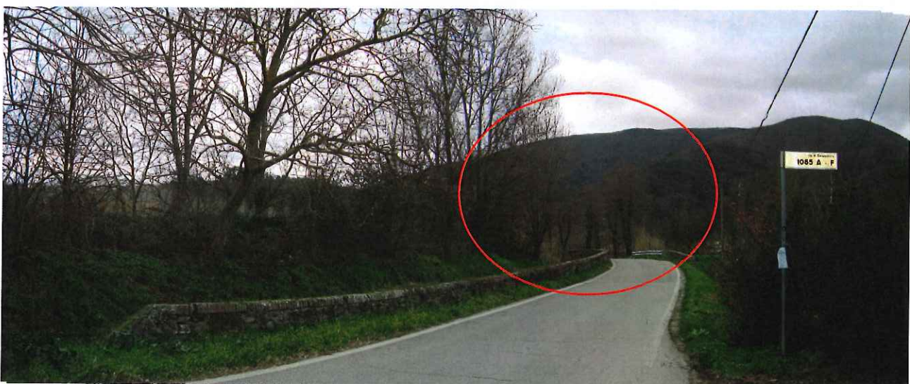
Figura 6.4-1: Vista lungo via di Cerasomma in direzione sud-est. E' evidenziata in rosso l'area di attraversamento del tracciato autorizzato da non realizzare. In secondo piano è visibile il sostegno n°60 della linea 132 kV esistente (coincidente con la variante localizzata in esame) posizionato in prossimità del cimitero di Cerasomma.
