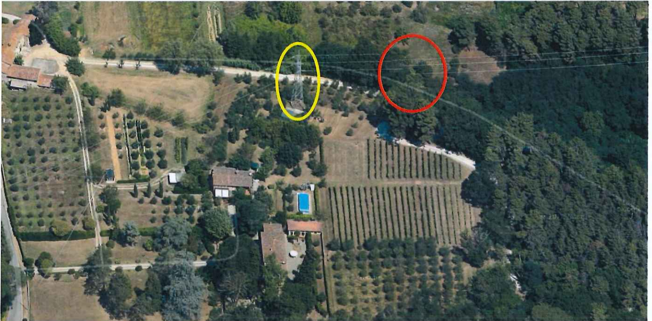
Figura 6.4-14: Villa Latmiral. In giallo è evidenziato il sostegno n. 58 della linea esistente, in rosso la nuova posizione approssimativa in seguito alla realizzazione del tracciato autorizzato.
