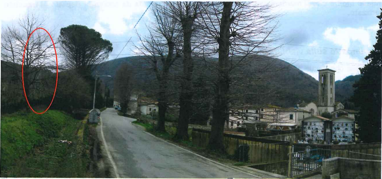
Figura 6.4-2: Vista lungo via di Cerasomma in direzione sud-est. In primo piano è visibile l'attraversamento della viabilità storica locale in prossimità del cimitero. E' evidenziato in rosso il sostegno n. 59 esistente.
