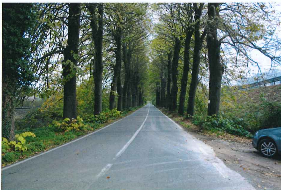
Figura 6.4-5: Vista della S.S.12 in direzione Lucca, in prossimità di Villa Poggio Luce. Si noti la presenza di folta vegetazione ai bordi stradali e il tracciato autostradale in rilevato.
