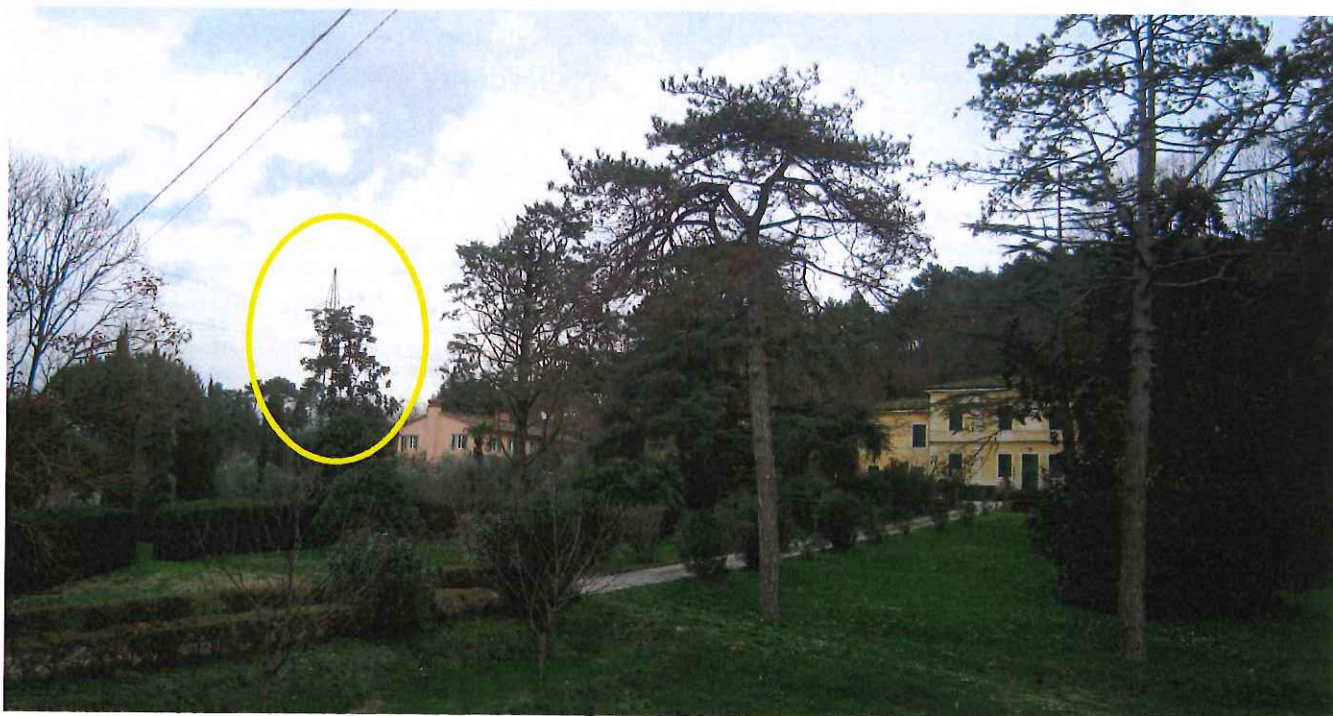
Figura 6.4-13: Villa Latmiral. In giallo è evidenziato il sostegno n. 58 della linea esistente
