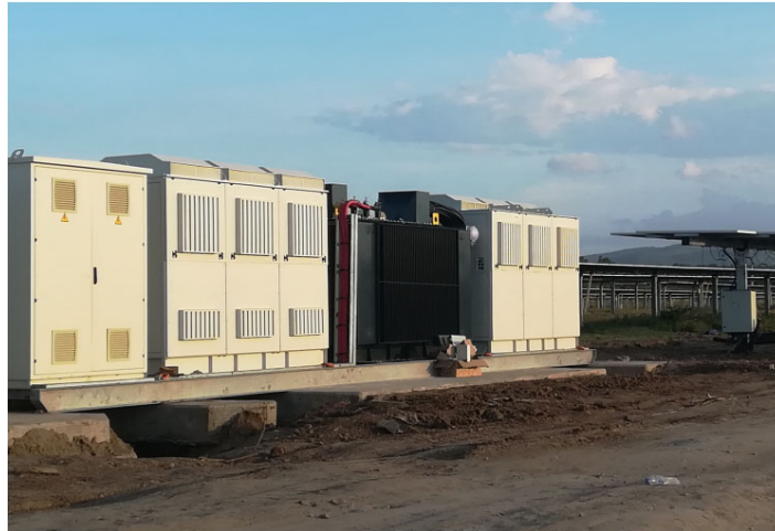
Figura 12 Esempio skid conversione
