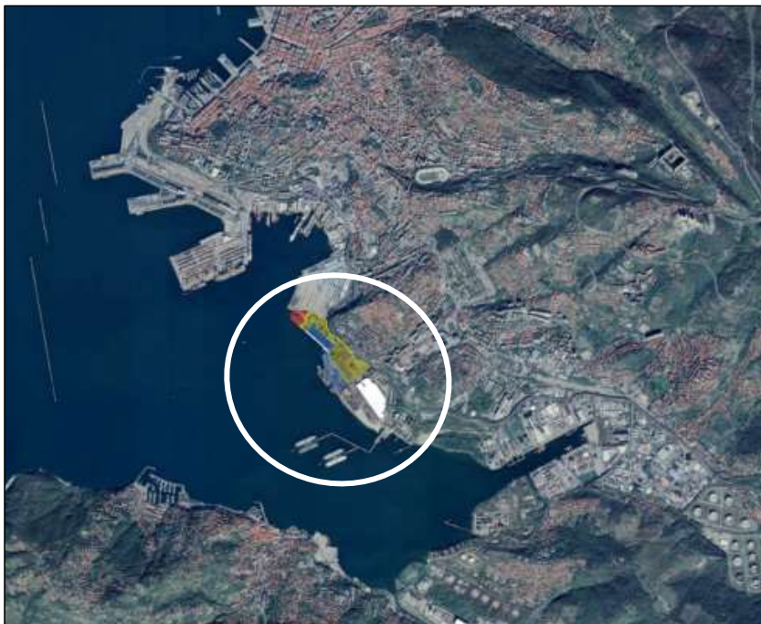
Figura 1 – Inquadramento delle aree oggetto di intervento
