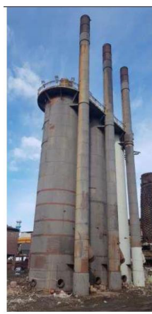
Figura 3. Cowper AFO3; i due più scuri in primo piano risalenti agli anni '20 del secolo scorso verranno conservati e destinati a memoria dell'archeologia industriale.
