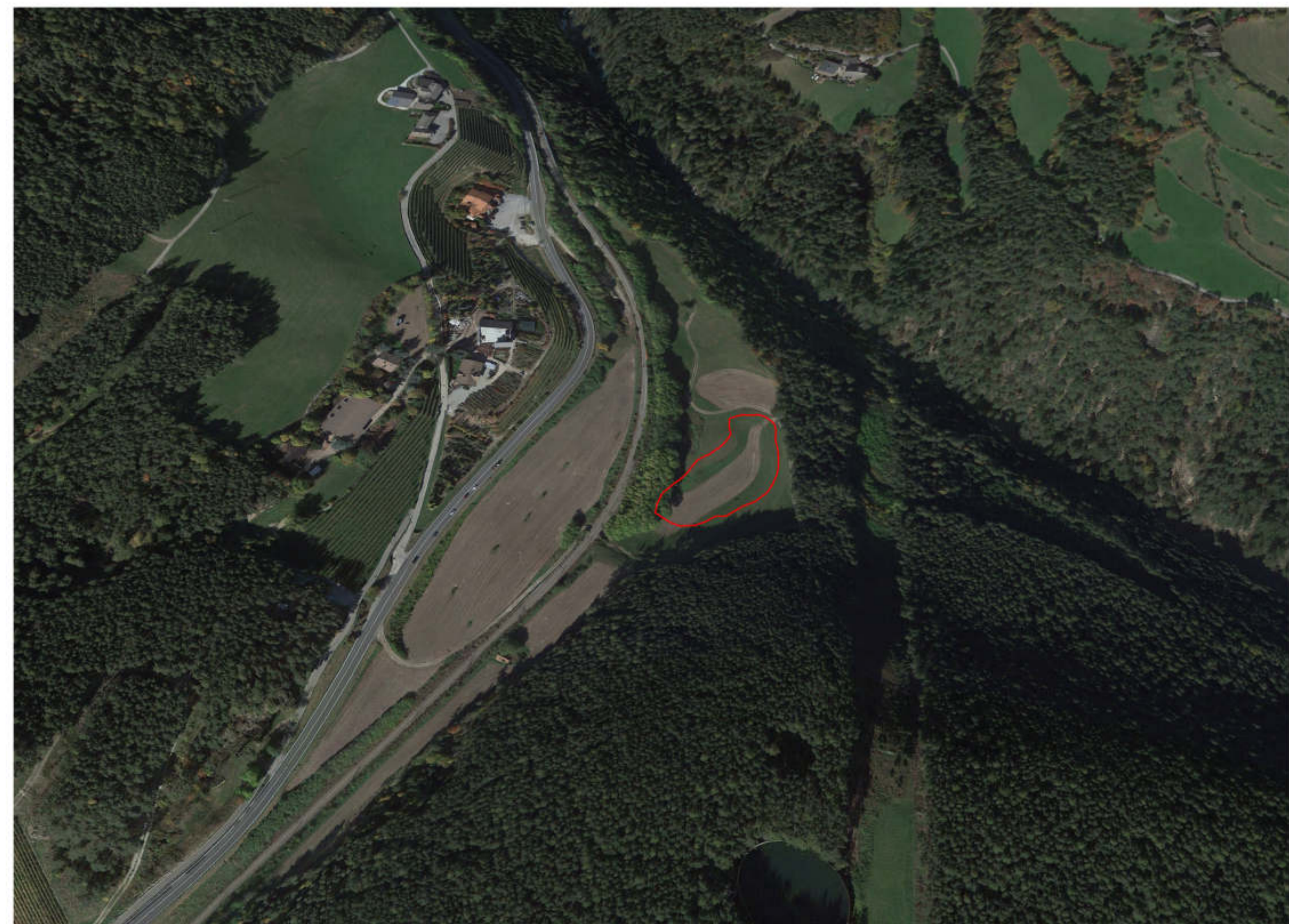
Foto aerea Google Earth
