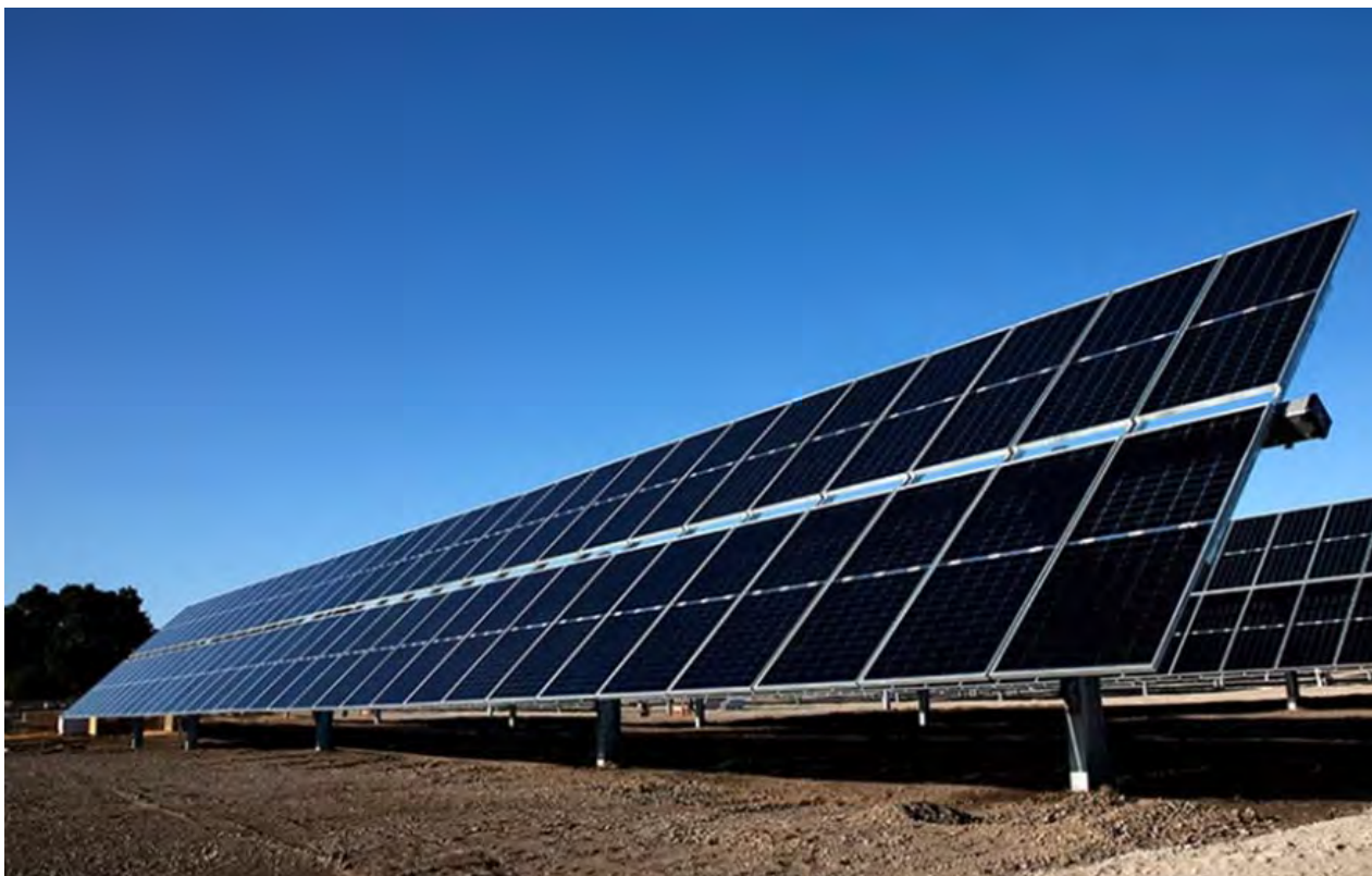
Figura 5.10 Tipico tracker fotovoltaico in configurazione "2-Portrait"
