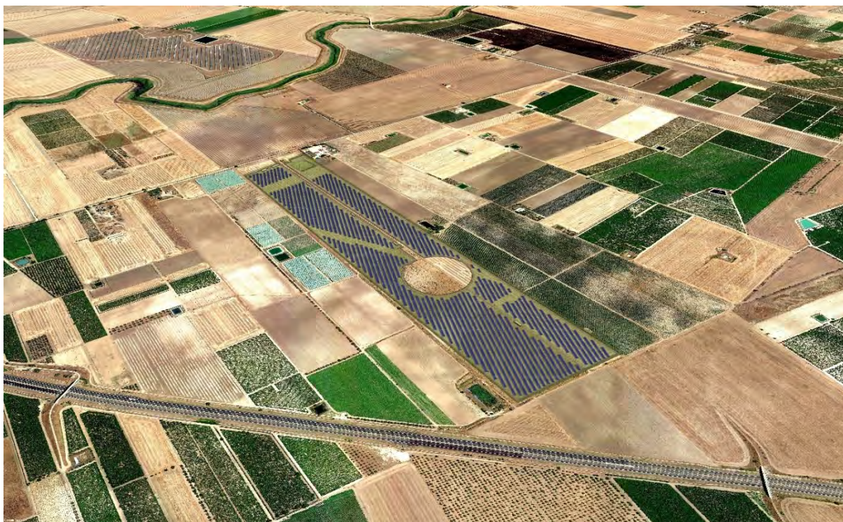
Figura 9.6: Vista aerea – Stato di fatto lotto 2
