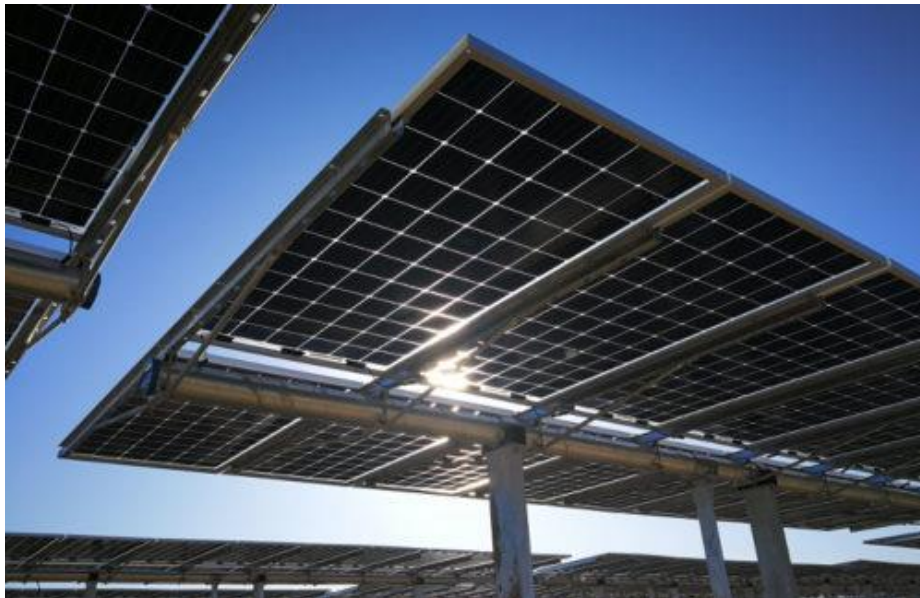
Figura 3.3 - Esempio di struttura a tracker monoassiale 2p
