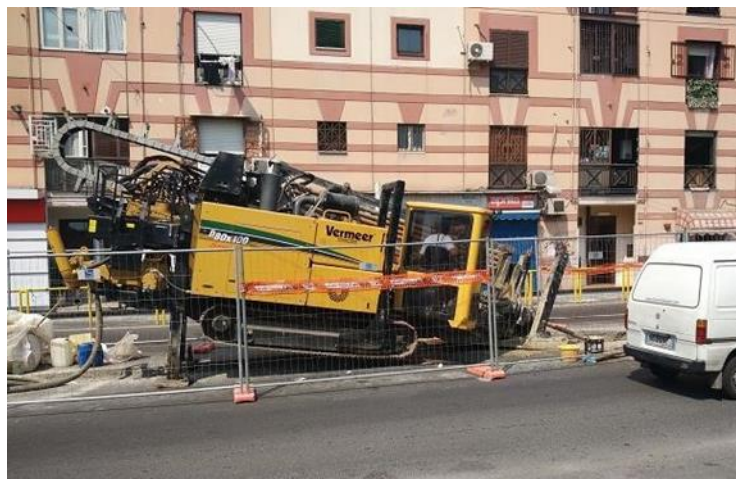
Fig. 21: Macchina Operatrice per esecuzione TOC
