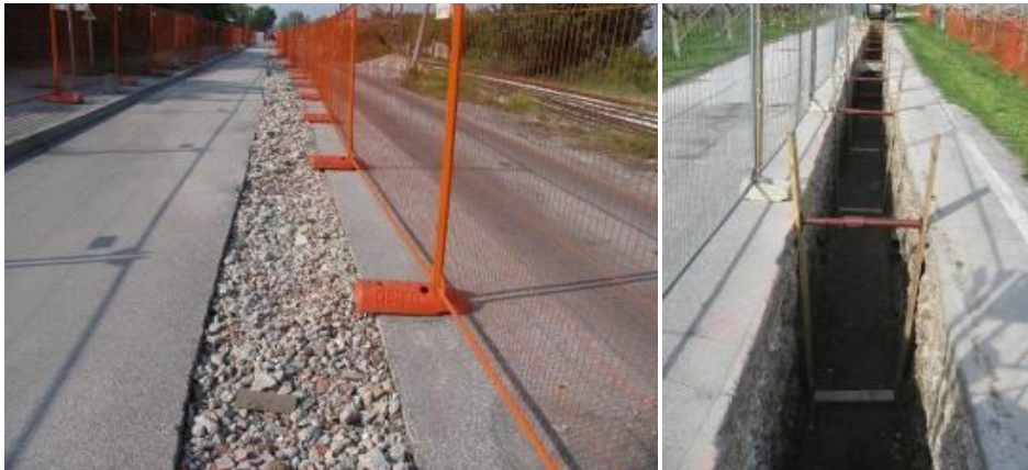
Fig. 20: Taglio dell'asfaltatura e scavo aperto
