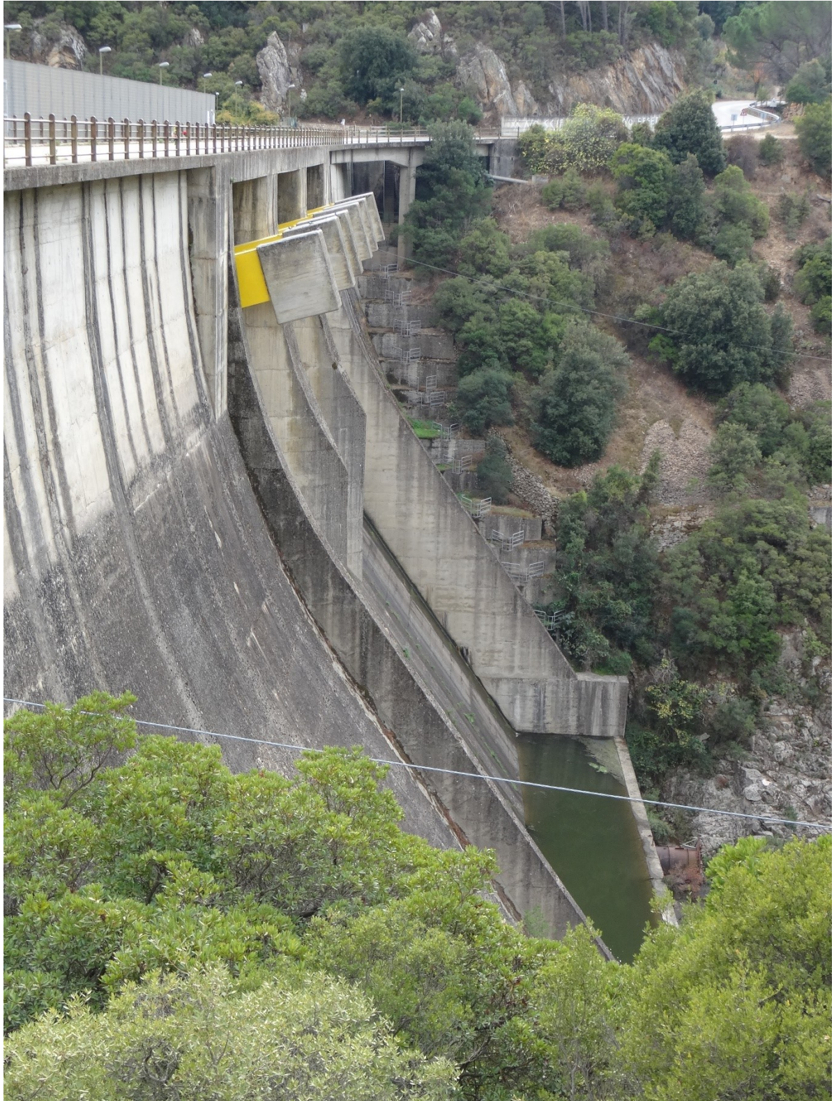
Paramento di valle.
