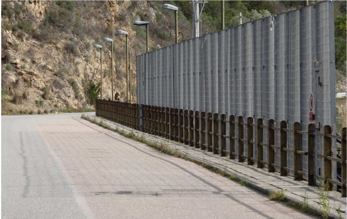
Attraversamento stradale della SP4 sul coronamento della diga.
