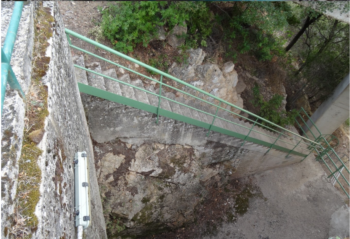
Scalette a ridosso del corpo della diga ad uso del personale.
