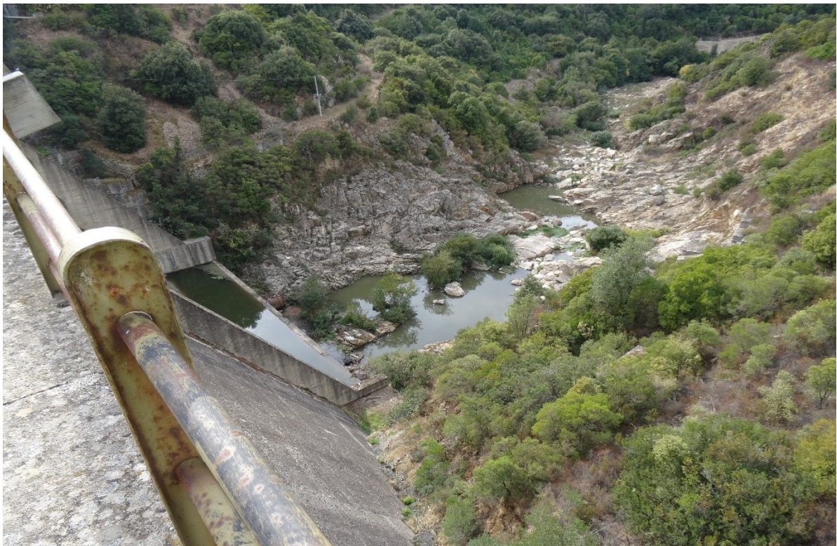
Fiume Taloro emissario, vista verso valle dal coronamento della diga.
