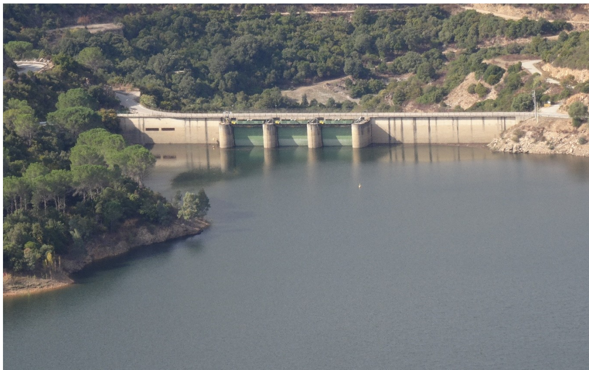
Paramento di monte della diga
