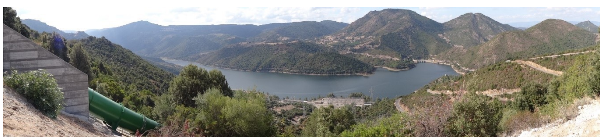
Vista panoramica da punto elevato sopra la centrale idroelettrica. Scorcio della condotta forzata a sinistra e vista sull'invaso di Cucchinadorza e sulla diga (a destra).
