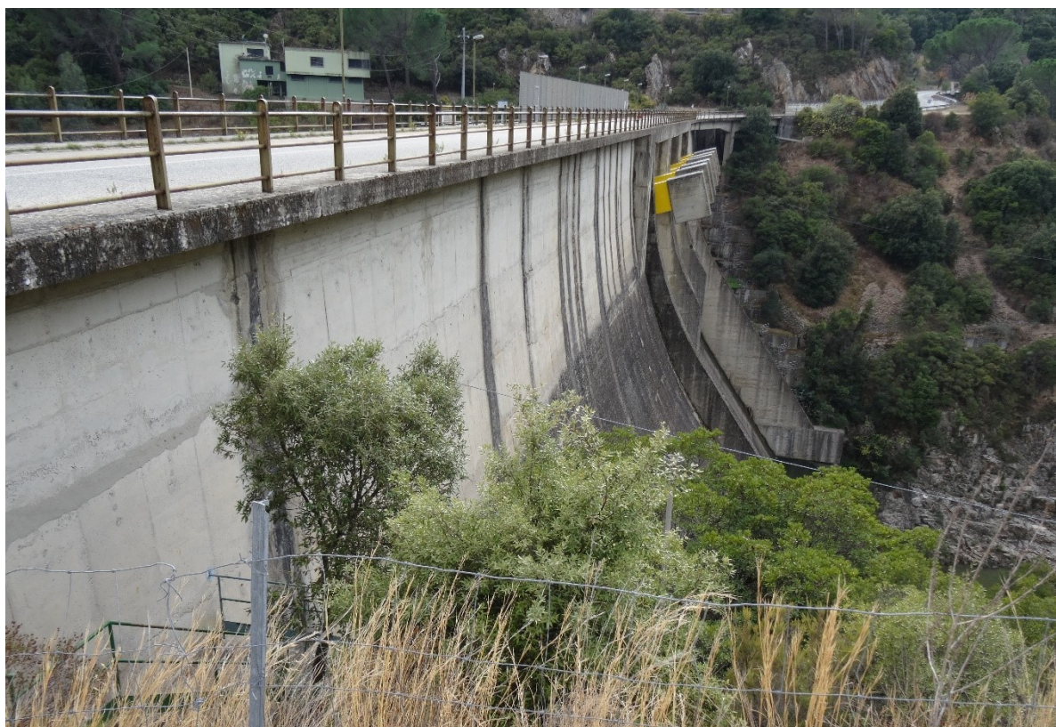
Paramento di valle
