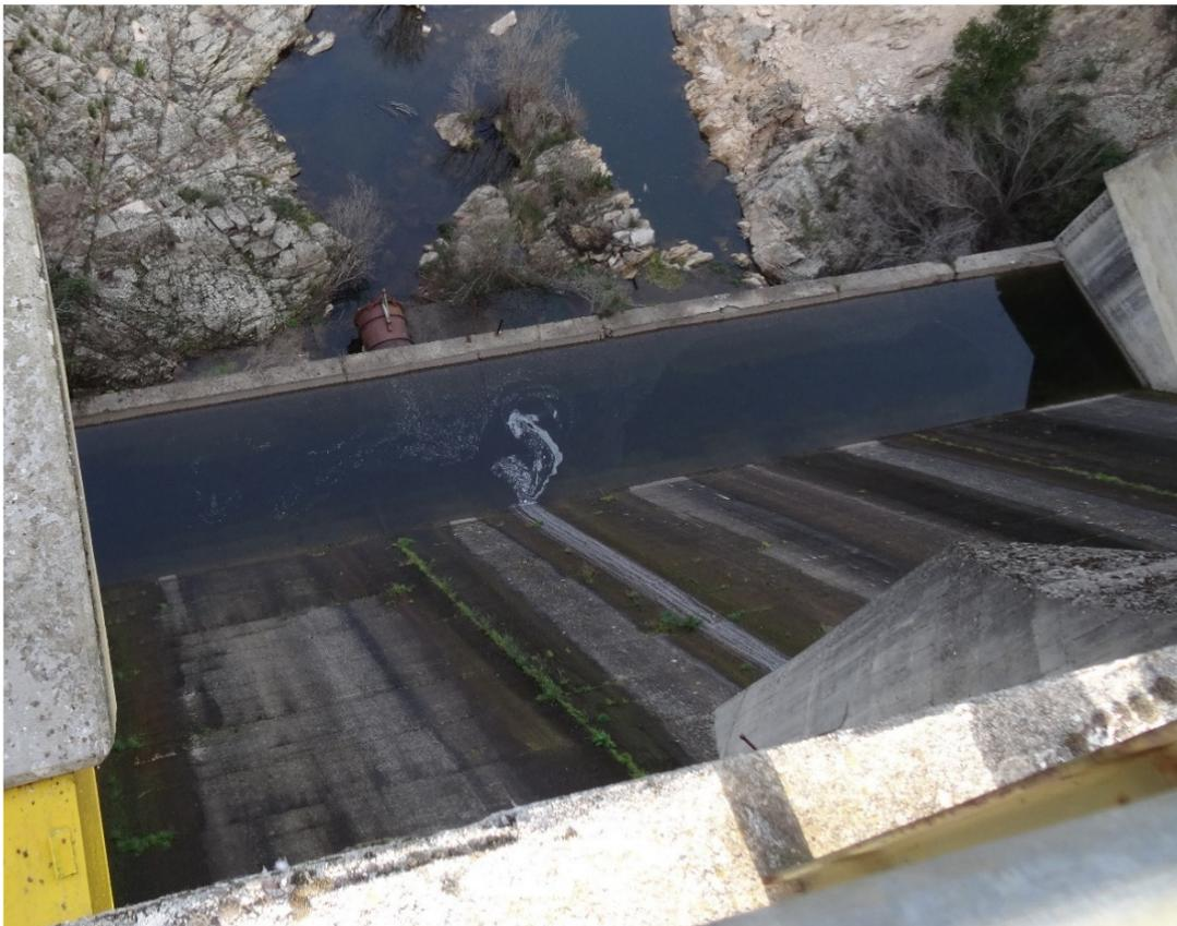
**Figura 24:** Ristagno d'acqua in prossimità del salto di sci dello scarico di superficie della diga.
