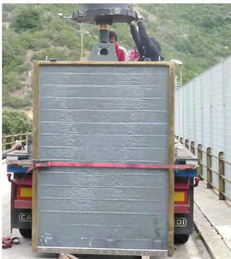
**Figura 12:** Riposizionamento del diaframma della paratoia dello scarico a seguito dei lavori di manutenzione eseguiti nel 2013.
