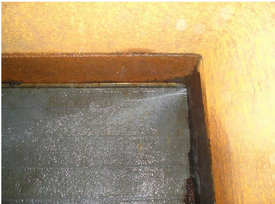
**Figura 14:** Venute d'acqua in corrispondenza del lato sinistro della paratoia di regolazione dello scarico di fondo sinistro, precedenti al danneggiamento del gargame superiore (intervento 2013).
