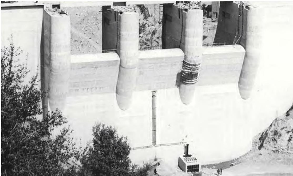
**Figura 9:** Vista da monte dello sfioratore e dell'opera scatolare di presa destra dello scarico di fondo, munita di paratoia con servomotore idraulico, della diga di Cucchinadorza (Leporati '62, [4]).
