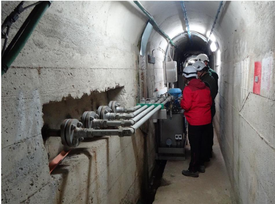
**Figura 6:** Centralina di comando delle paratoie dello scarico di fondo (17 marzo 2022).
