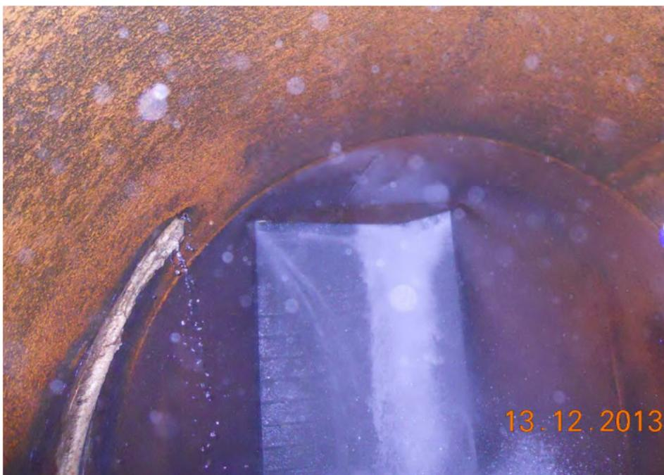
**Figura 15:** Perdite in corrispondenza della paratoia di regolazione dello scarico di fondo sinistro, dopo il danneggiamento conseguente alle prime manovre (intervento 2013).
