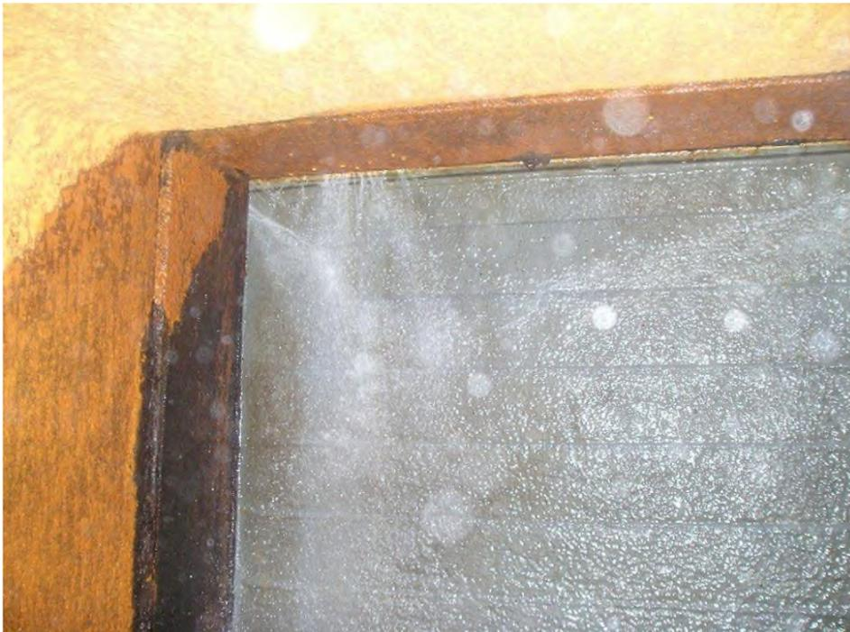
**Figura 13:** Venute d'acqua in corrispondenza del lato destro della paratoia di regolazione dello scarico di fondo sinistro, precedenti al danneggiamento del gargame superiore (intervento 2013).
