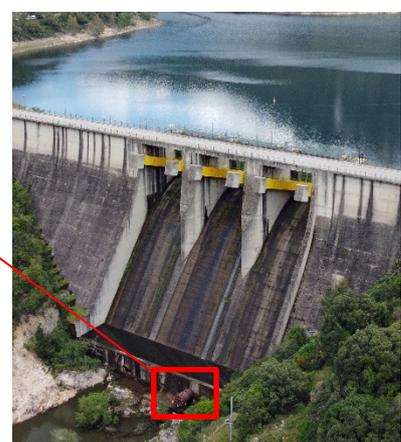
In queste condizioni la capacità di efflusso dello scarico di fondo è ridotta al 50%.
