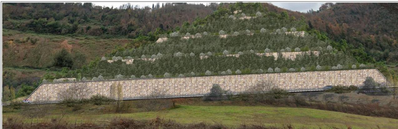
La sistemazione ambientale prevede il rivestimento in pietra calcarea del primo livello di taglio del versante, un rinverdimento mediante rampicanti dei livelli successivi al primo, frapposti alla rete chiodata, un rinverdimento con arbusti autoctoni di piccola taglia dell'ultimo livello che meglio si adattano e si conformano alla vegetazione della sommità del versante.
