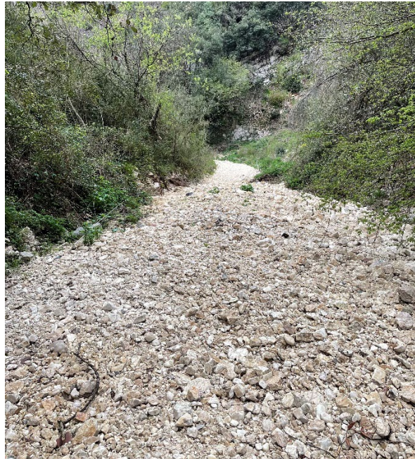
Figura 8: Fondo alveo del torrente fosso dei Cerri in corrispondenza dell'attraversamento B.105.
