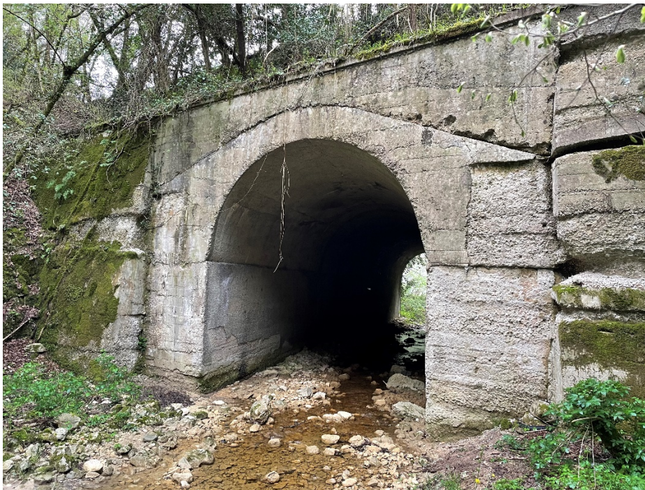
Figura 5: Attraversamento fosso dei Cerri B.111 allo stato di fatto.
