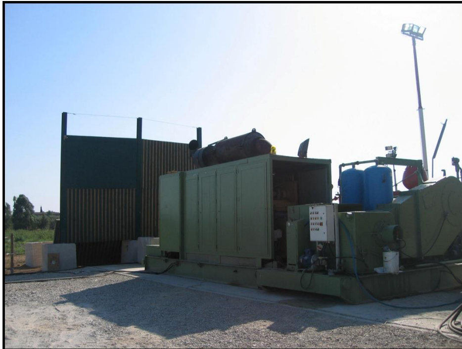
Figura 5.3c Generatori Elettrici ad Alta Insonorizzazione
