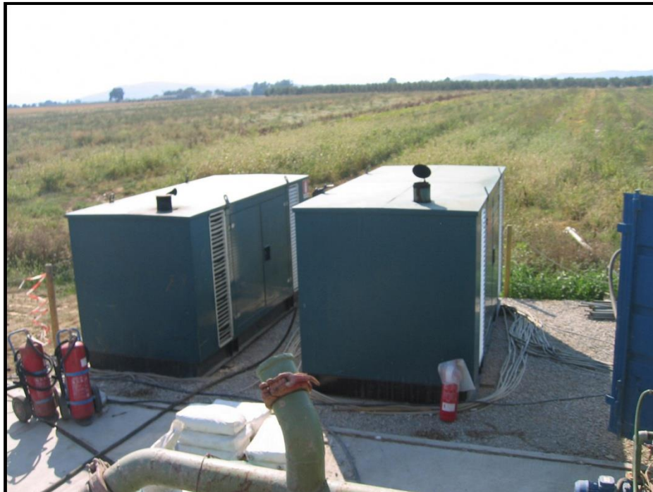
Figura 5.3c Generatori Elettrici ad Alta Insonorizzazione
