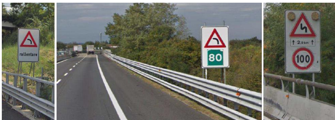
Segnaletica di curve pericolose rafforzate con velocità consigliate, limiti di velocità e lampeggianti
