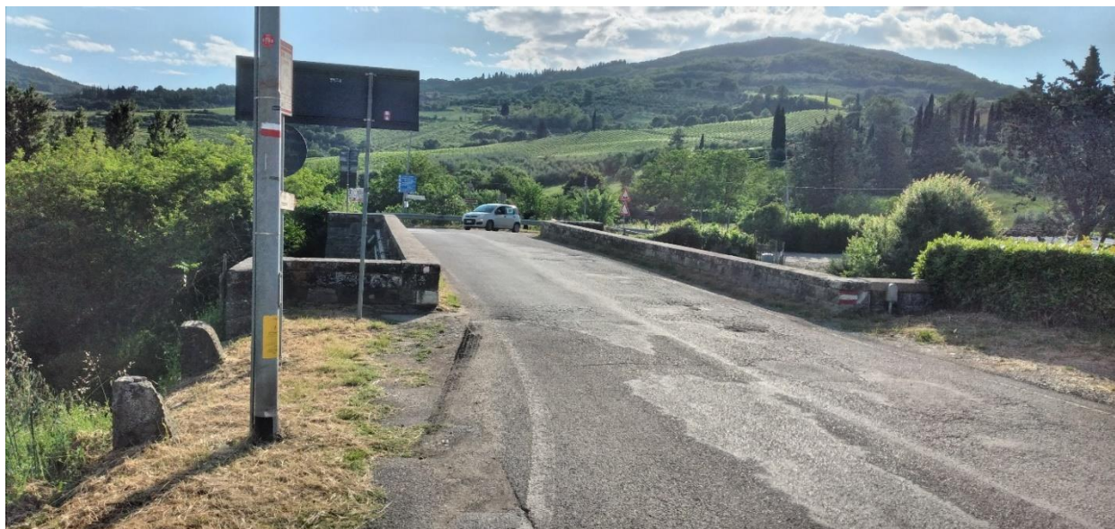
Foto 26 ponte storico - Torrente Argemenna
